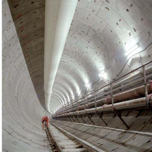
**Figura 13 Vista de um túnel do CTRL executado em anéis de concreto pré-moldados reforçados com fibras de aço<sup>105</sup>.**
