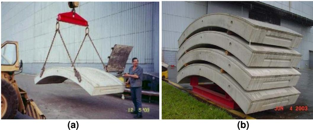
**Figura 40 (a) içamento e (b) estocagem simulando etapa no pátio da planta de produção.**
