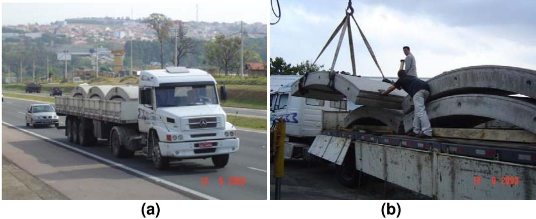
Figura 47 (a) Transporte das aduelas em rodovia estadual e (b) descarregamento das aduelas no pátio da Unicamp, para realização dos ensaios.
