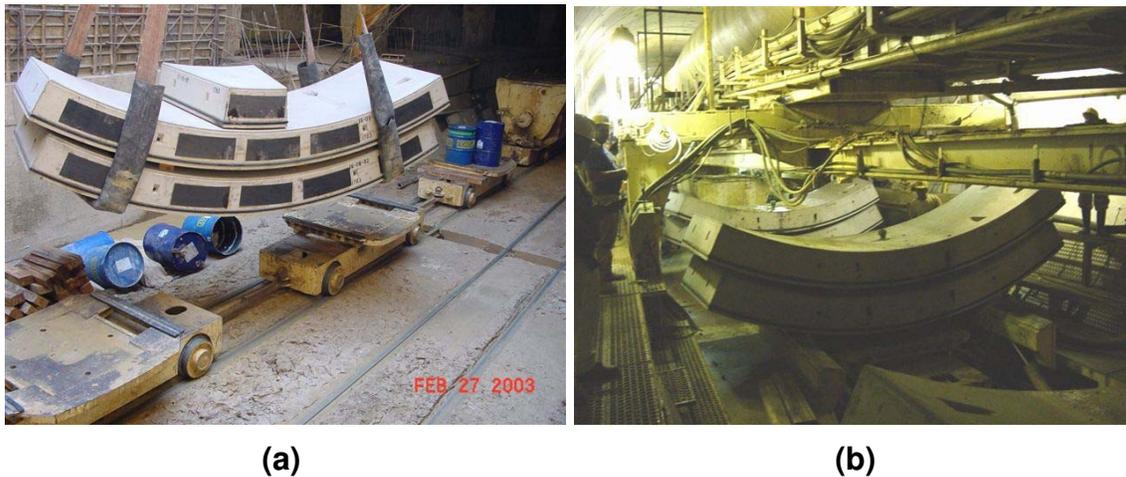
Figura 48 (a) Penúltima etapa de içamento e transporte<sup>159</sup> das aduelas e (b) chegada até a máquina tuneladora antes do eretor.
