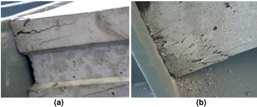
**Figura 57 (a) e (b) Esmagamentos nos apoios que provocaram os deslocamentos horizontais citados.**
