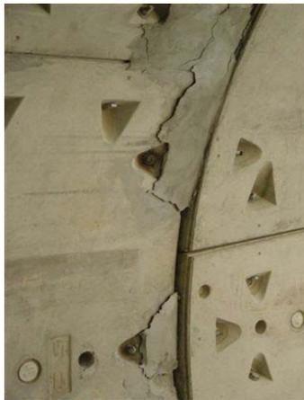
**Figura 2 Reparos nas aduelas após a montagem do anel (mal executados), indesejáveis e de alto custo.**
