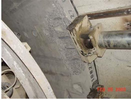
**Figura 1 Quebra durante a instalação da aduela em virtude da zona fragilizada no contato da armadura com o concreto<sup>54</sup>.**
