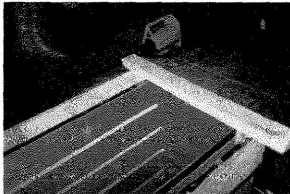
3.5 - Detalhe mostrando a parte interna da fôrma, e as fitas adesivas utilizadas para impedir o vazamento da nata de cimento.
