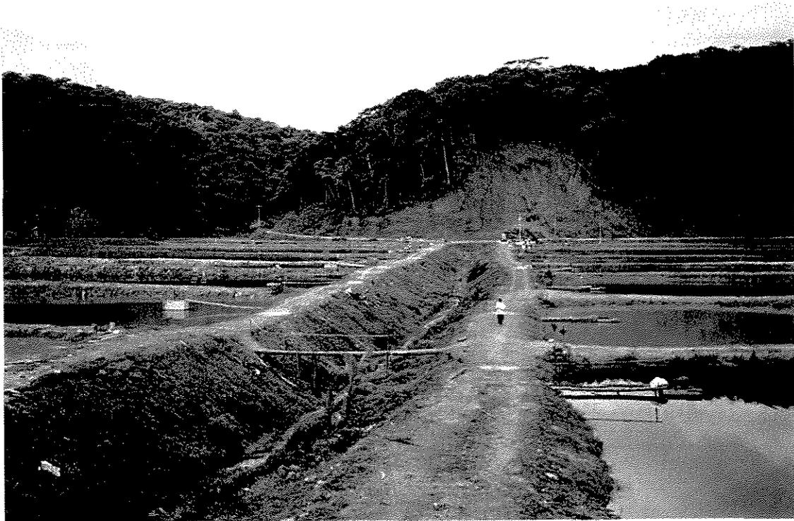
Figura 14 - Erosão e desmatamento causados por empréstimo de material para a construção das barragens e tanques II - Período de seca.
