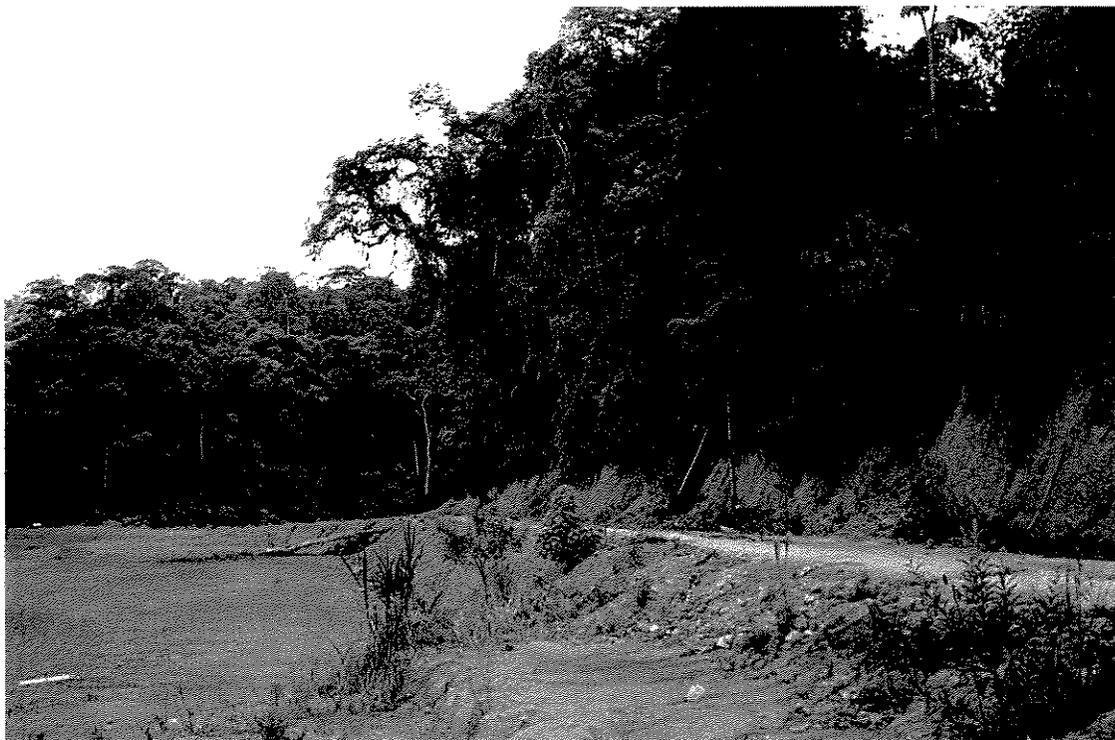
Figura 9 - Erosão em taludes de estradas I.
