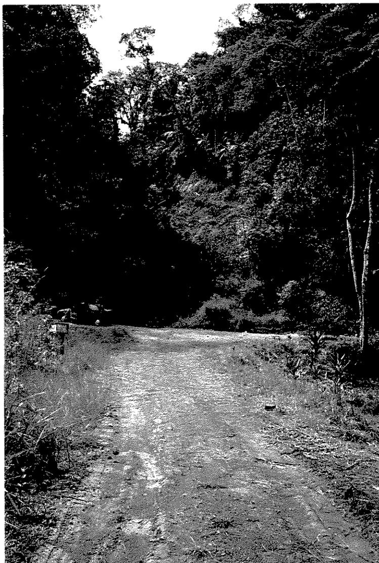
Figura 16 - Erosão e desmatamento causados por empréstimo de material para a construção das barragens e tanques IV.
