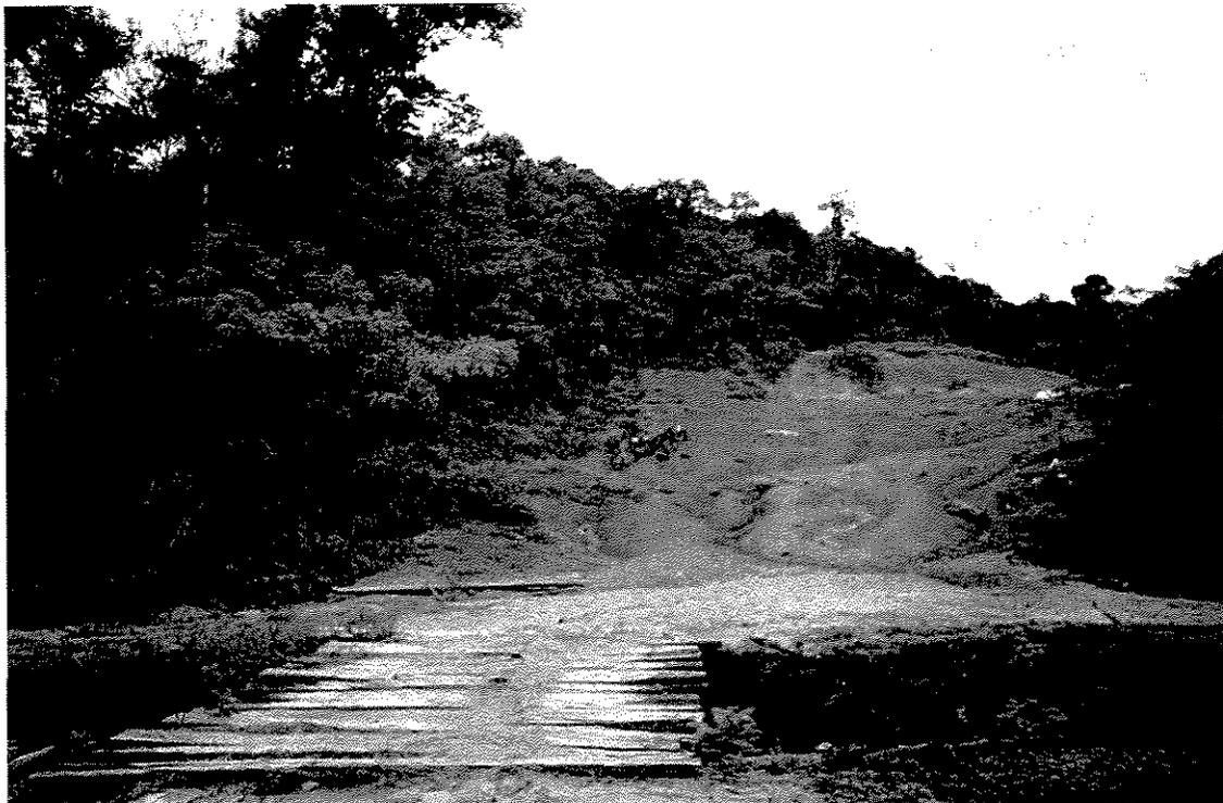
Figura 15 - Erosão e desmatamento causados por empréstimo de material para a construção das barragens e tanques III.
