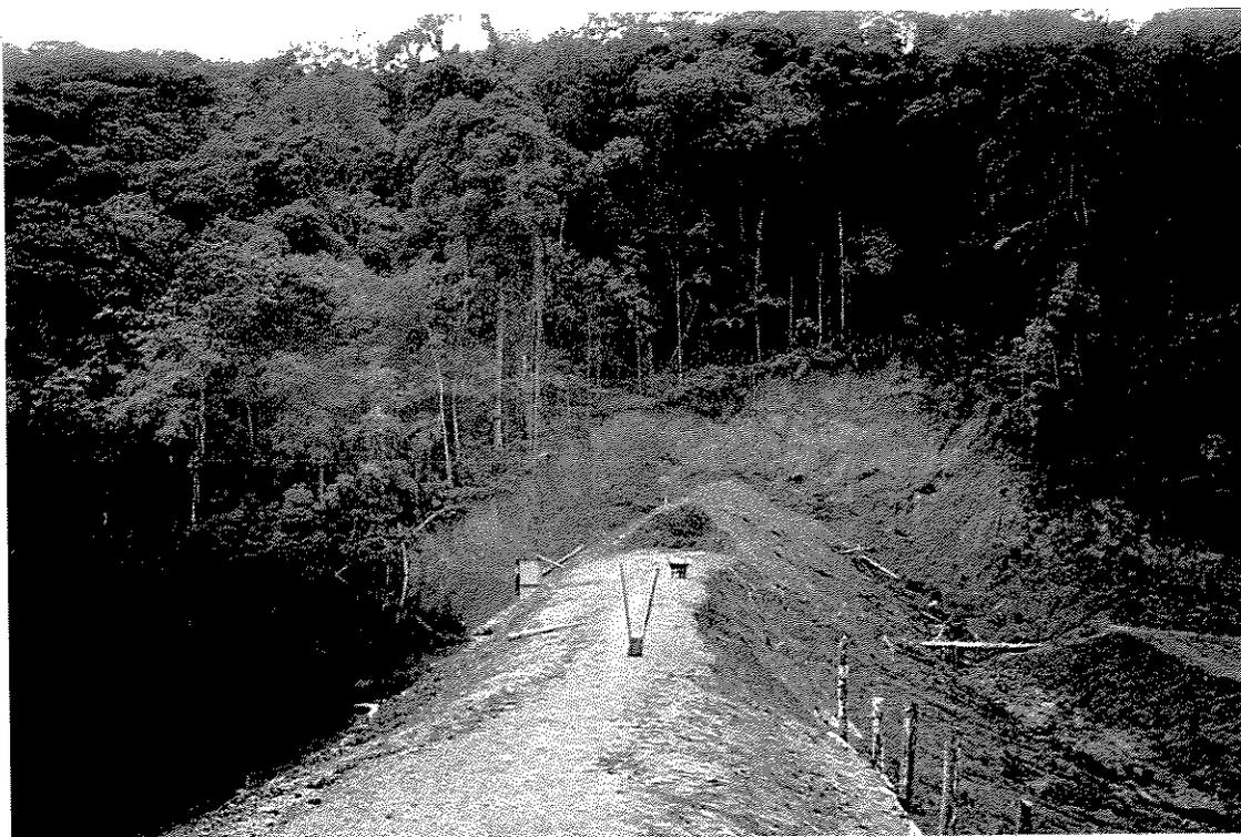
Figura 11 - Erosão em barragem de abastecimento dos tanques - Período de seca.
