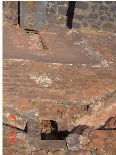
Figura 112 - ralo para captação de águas e canaletas no terreiro inferior
