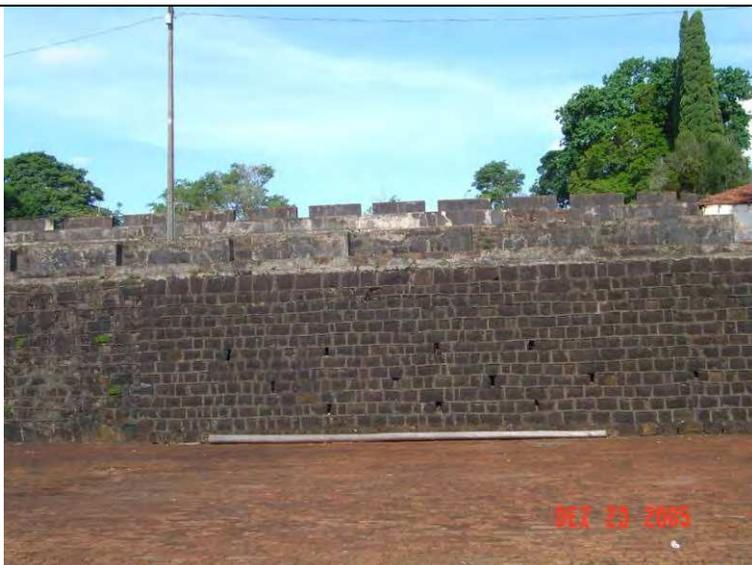
**Descrição:** Canaletas em alvenaria de tijolos e concreto sobre muro de pedra
