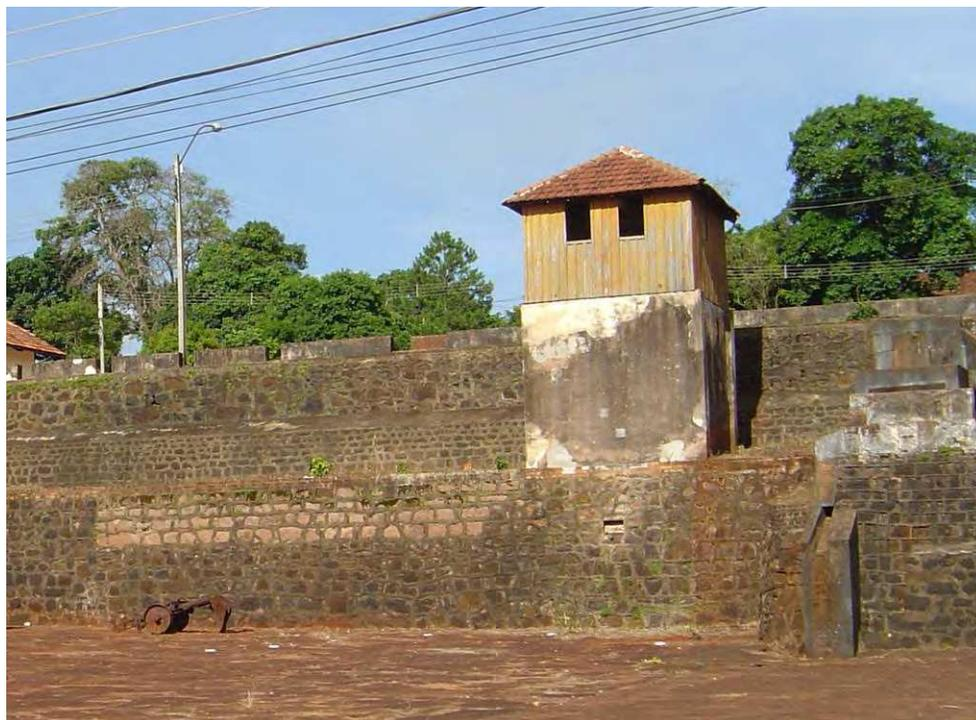
**Figura 125 - Tulha de passagem, pequena. A parte refeita do muro (pedras mais claras) é o provável local da segunda tulha, desaparecida completamente.**
