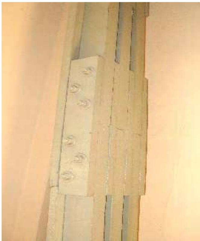
**Figura 116: Junção das duas peças de madeira.**
