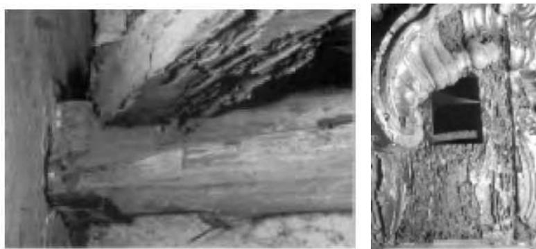
**Figura 66: Degradações causadas por cupins.**
