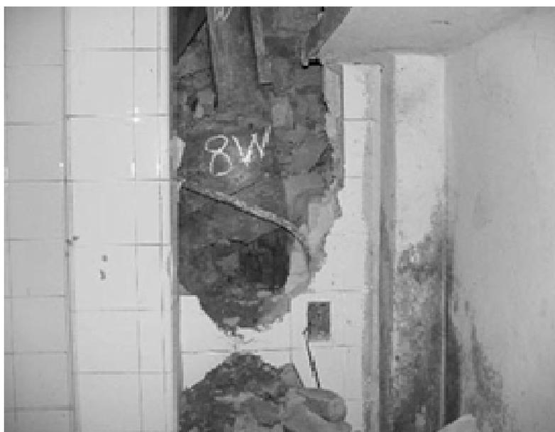
**Figura 108: Apoios do arco encoberto por parede.**
