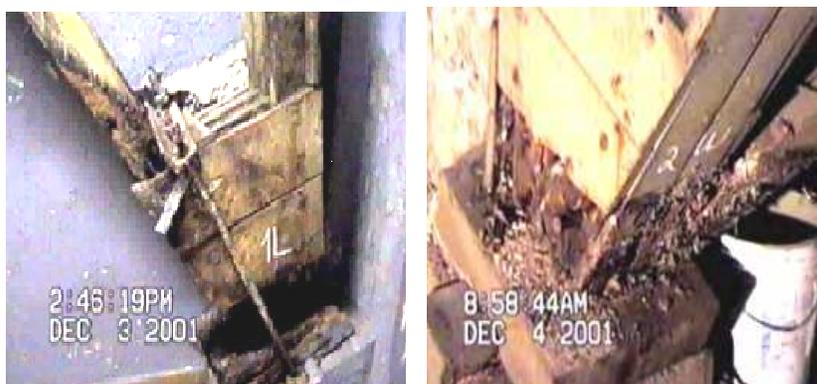
**Figura 113: Apoios deteriorados: apoio 1L e apoio 2W, respectivamente.**
