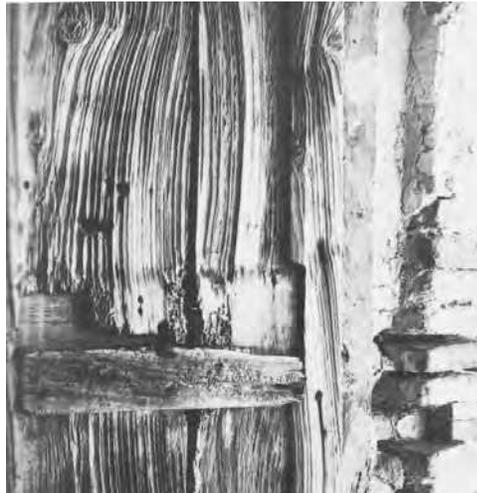
**Figura 36: Efeito destrutivo da radiação ultra violeta em uma peça de madeira não tratada.**
