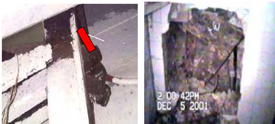
**Figura 114: a) Madeira carbonizada por incêndio; b) Apoio 7W embutido na parede.**
