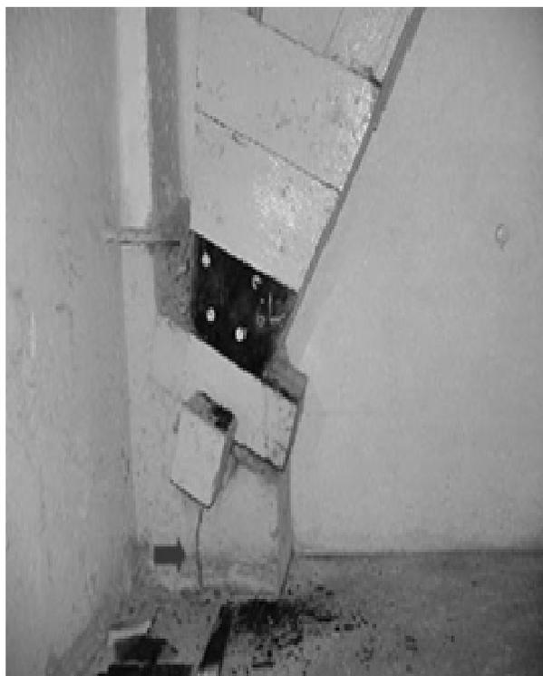
**Figura 109: Apoios do arco encoberto por parede.
