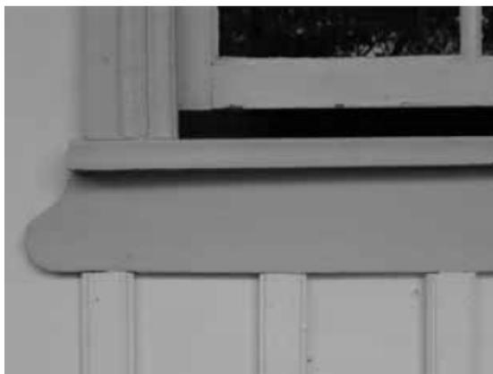
**Figura 15: Detalhe do sistema “mata-junta” e esquadria de madeira, Curitiba, PR.
