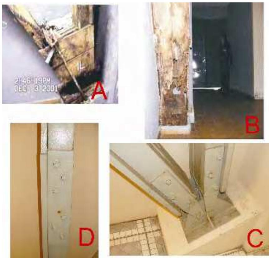
**Figura 122: A e B – Duas vistas de peças totalmente deteriorada, em 2001; C – Peça com apoios substituídos, 2009; D – Peça com emenda onde foi substituída a parte deteriorada.**
