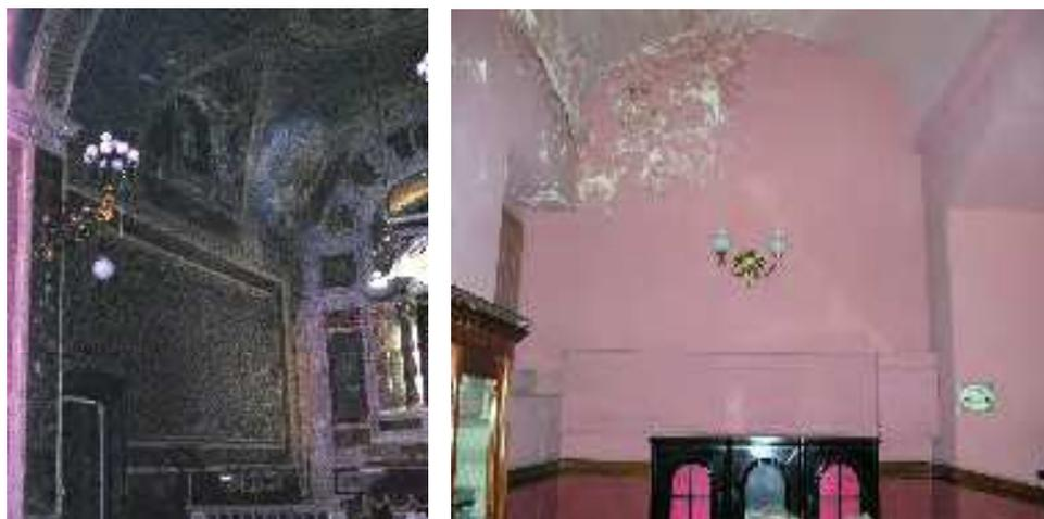
**Figura 86: Infiltrações nas abobadas do Capela transepto e Memorial do órgão, respectivamente.
