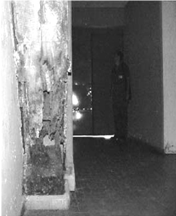
**Figura 110: Apoio de arco intensamente deteriorado (Apoio 1L).
