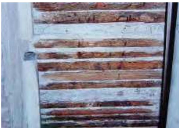
**Figura 03: Consolidação com resina do forro na Villa Penteado.**
