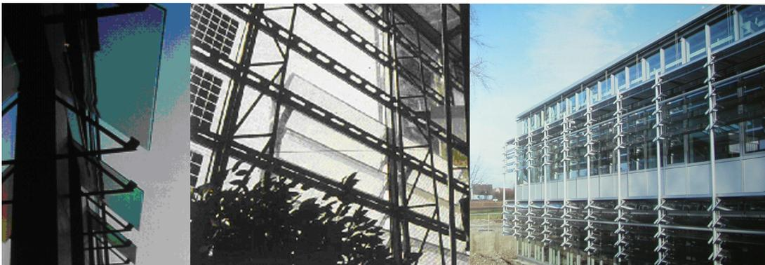
**Figura 3.82 - Brise de vidro com filme holográfico “Daylight Guidance Systems”, David Carter Society of Light and Lighting, East Anglia Region 2004. Fonte: KOSTER, 2004**
