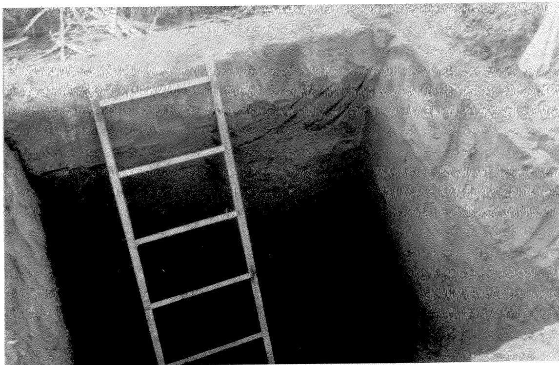
**FIGURA 3.2** - Abertura de trincheira para instalação dos coletores.
