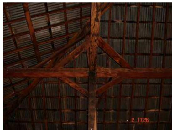
Figura 38 – Encaixe do madeiramento do telhado (tulha 02)
