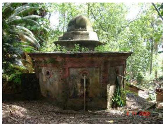
Figura 10 – Reservatório de água
