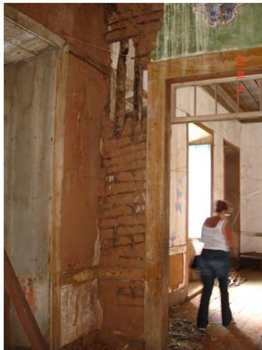
Figura 27 – Detalhe para a parede de pau-a-pique
