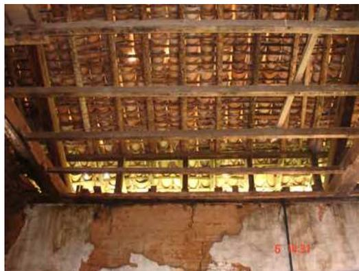
Figura 35 – Detalhe telhado (caibros de coqueiro)
