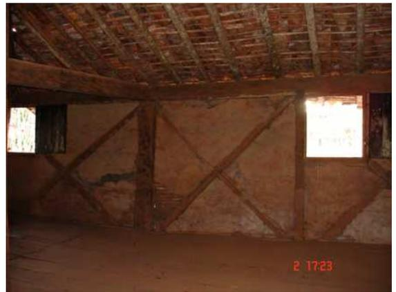
FIGURA 44 – Sistema construtivo "enxaimel".
