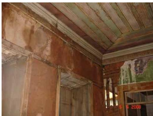
Figura 23 – Detalhe da umidade em pintura interna
