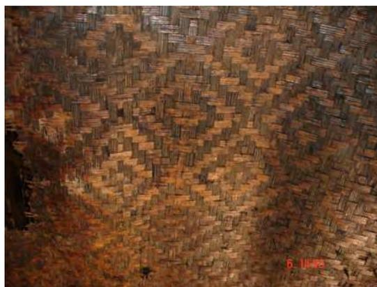
Figura 39 – Detalhe forro jicara (palha coqueiro trançada)
