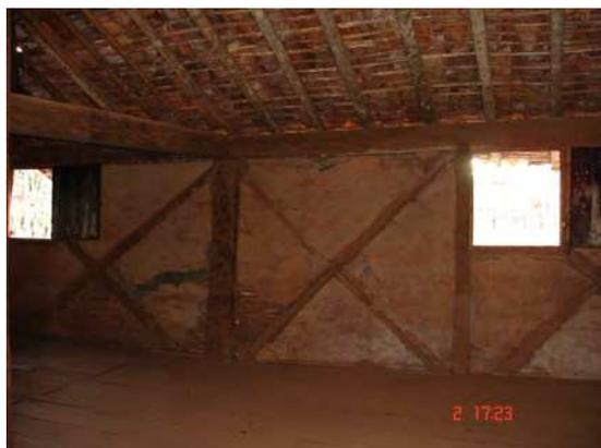
Figura 33 – Vista interna da tulha 01 (parede enxaimel)
