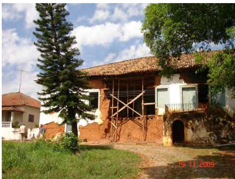
FIGURA 111 – Vista da fachada principal da casa-sede da fazenda, após a queda parede de taipa.
