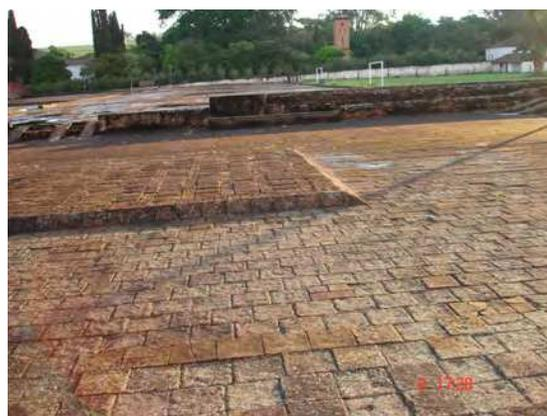
Figura 40 – Detalhe para o piso do terreiro (lajota cerâmica)
