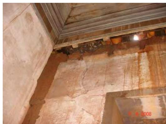
Figura 36 – Detalhe a parede lateral comprometida
