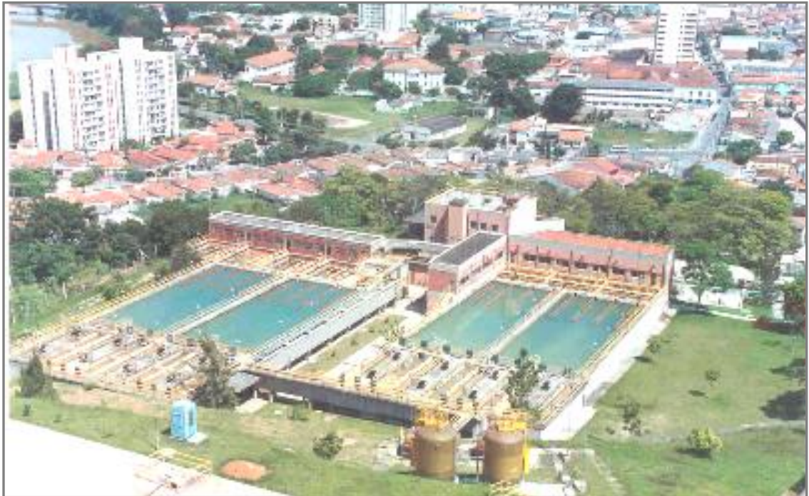
FIGURA 3.8 - Estação de Tratamento de Água - ETA Central - Jacareí -SP, com suas duas alas contíguas de tratamento (ETA I e ETA II)
