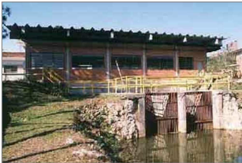
FIGURA 3.6 - Canal e gradeamento da Estação de Captação de Água da ETA Central, situada na margem direita do Rio Paraíba do Sul - Jacareí - São Paulo
