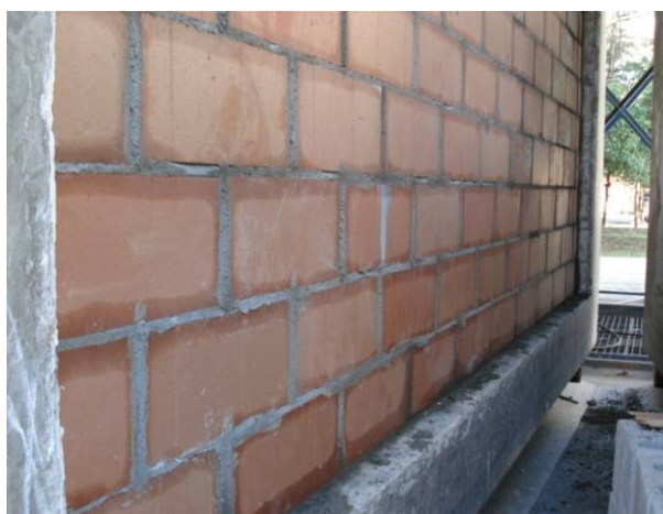
Figura 7.14: Montagem da parede no pórtico do laboratório.
