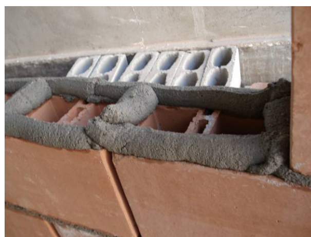
Figura 6.3: Montagem de parede para teste de isolamento sonora, com detalhe à colocação da argamassa.
