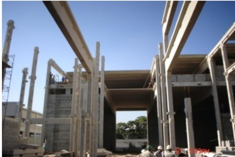
*Figura 4.11 Exemplo da montagem de estrutura de supermercados*
