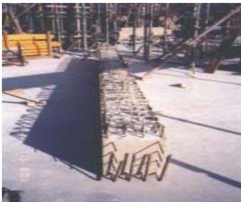
*Figura 4.8 Exemplo de uma viga armada concretada*
