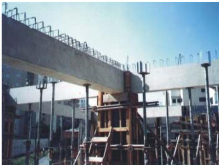
*Figura 4.10 Exemplo da montagem de uma viga armada em obra*
