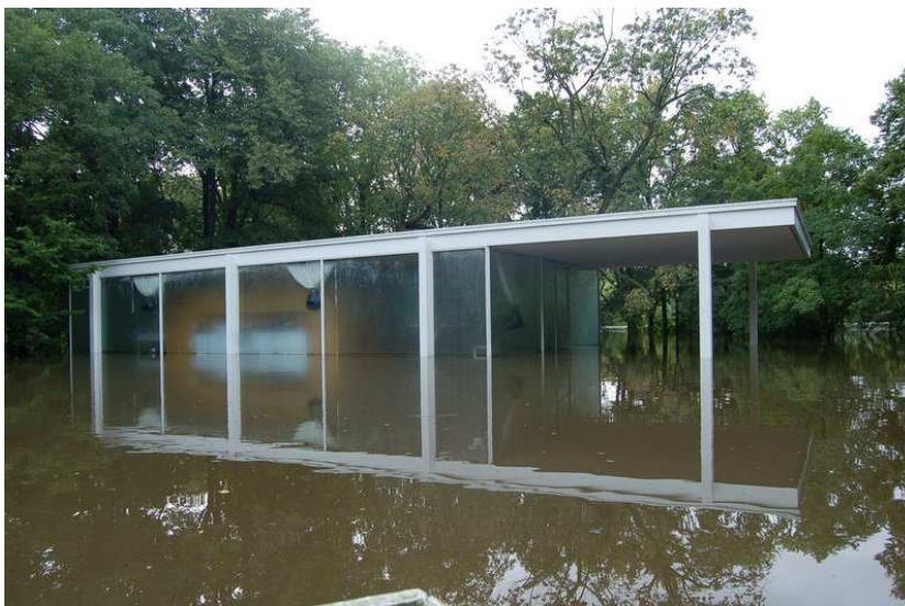
Figura 29. Casa Farnsworth: inundação em 2008
