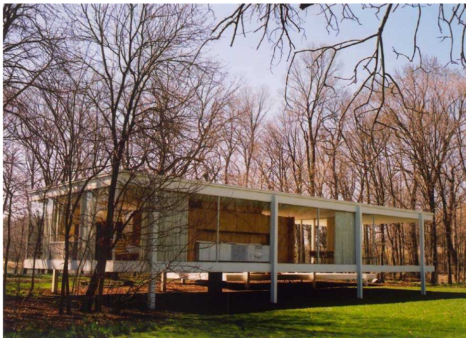
Figura 28. Casa Farnsworth: imagem externa
