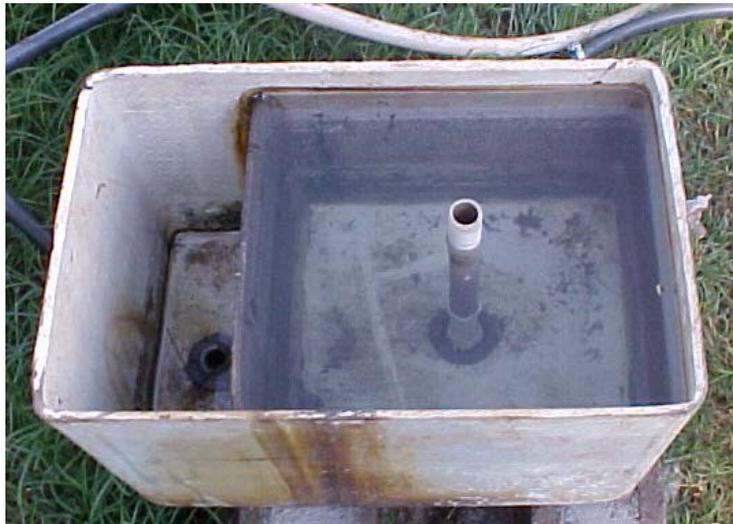
Figura 4. Foto do dosador do pré-filtro de pedregulho.
