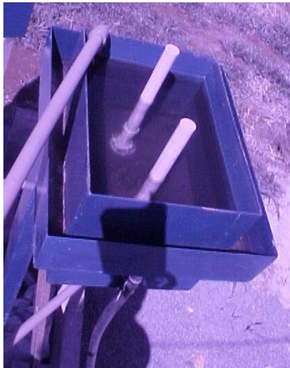
Figura 9. Foto da caixa de derivação de entrada dos filtros lentos.
