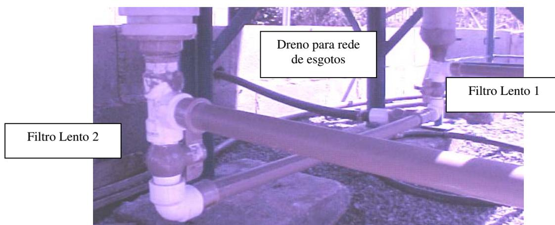
Figura 11. Foto sistema de drenagem dos filtros lentos.
