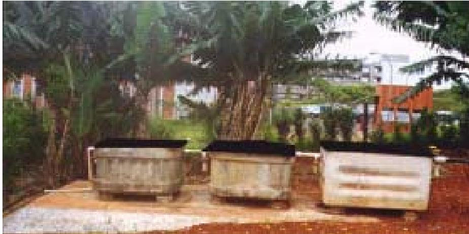
Figura 1. Tanque séptico compartimentado (in VALENTIN,2003).
