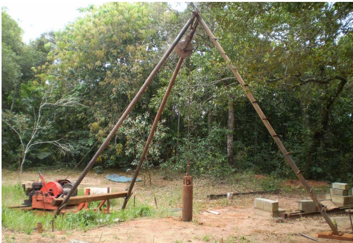
Figura 4.5 – Equipamento para execução de estaca apiloadada.
