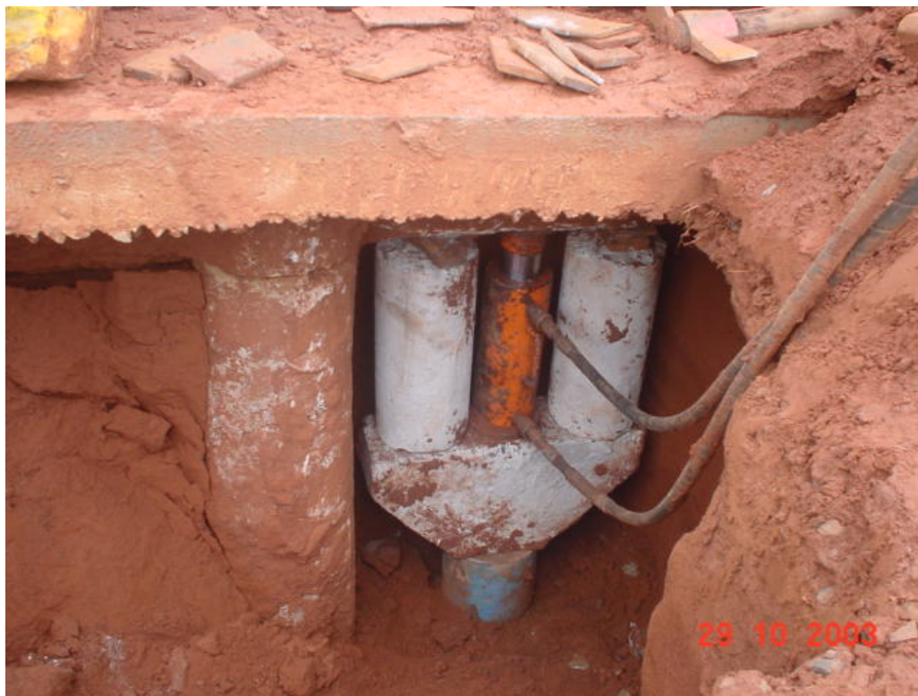
Figura 2.25 - Consolidação e encunhamento com chapas metálicas
