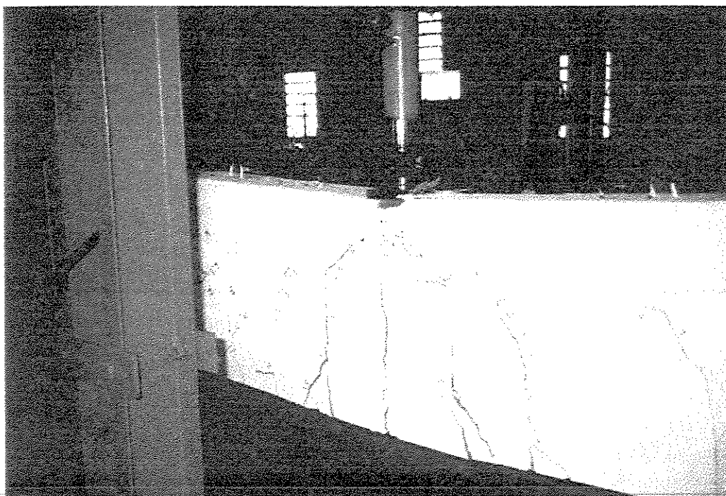
Figura 6-3 VIGA 3BL-FL APÓS ENSAIO
