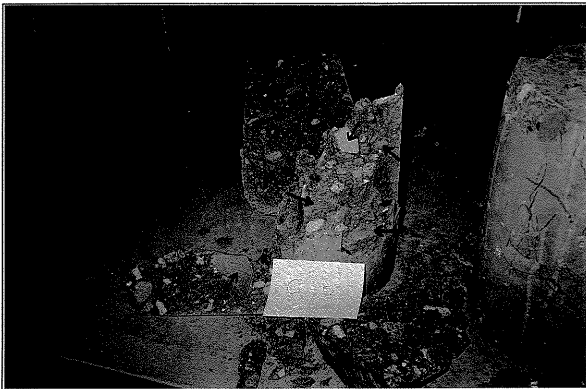
FOTO 5 - Detalhe da falta de aderência dos materiais cerâmicos polidos presentes no concreto.
