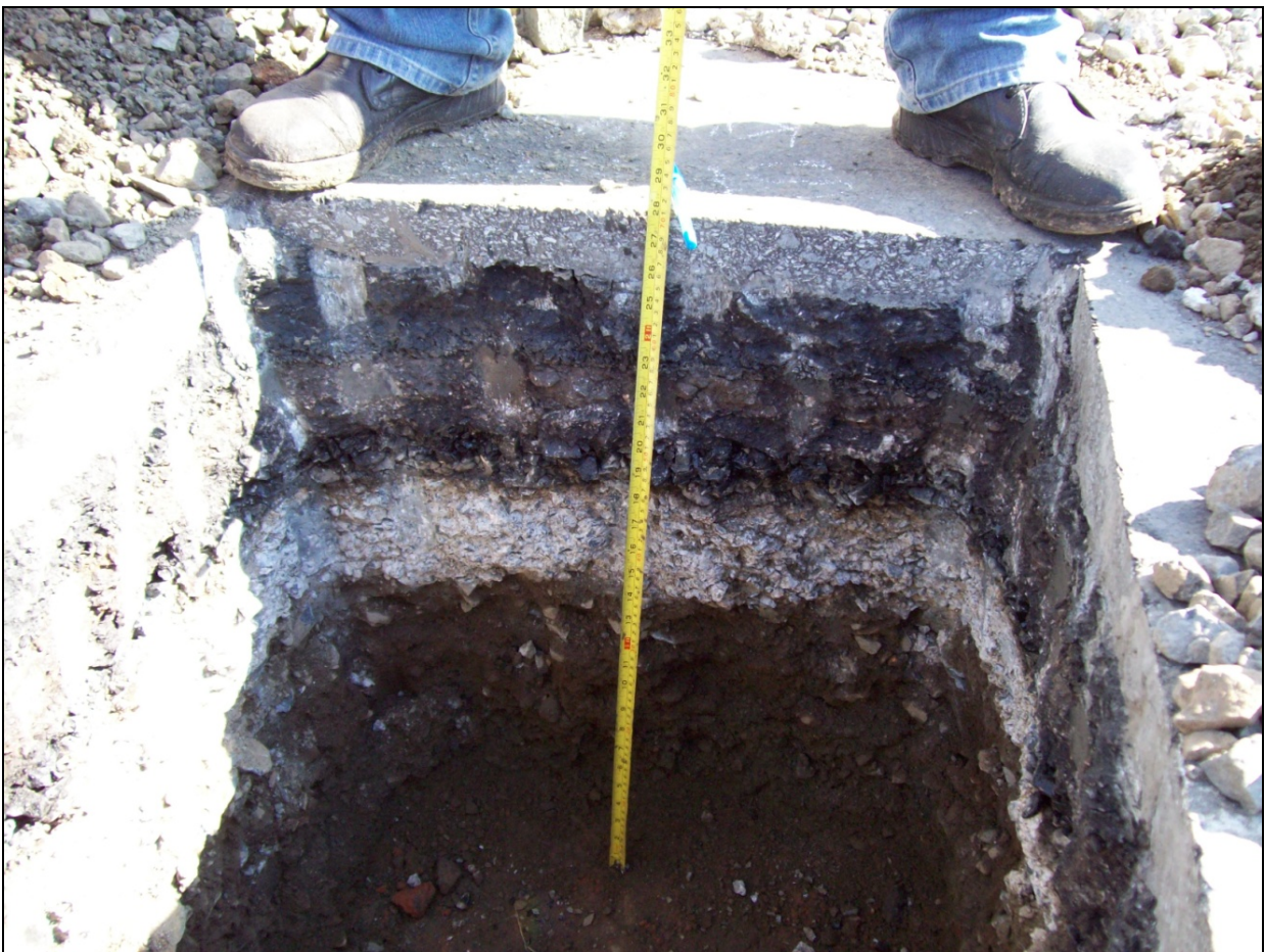
Figura 2.2 – Avaliação destrutiva do pavimento flexível – poço de sondagem.
