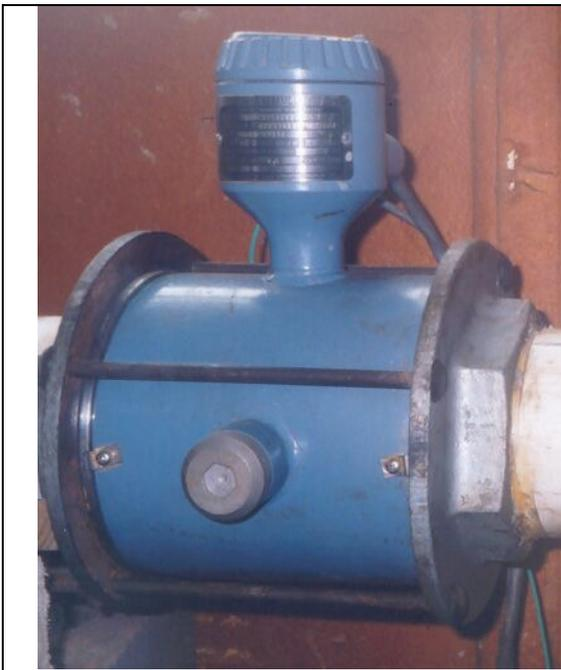
Figura 4.13 – Elemento Primário do Medidor Eletromagnético
