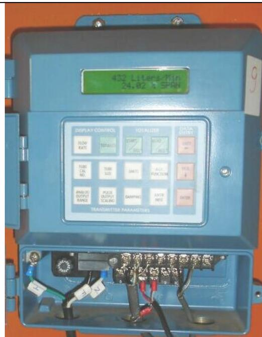
Figura 4.14 – Elemento secundário do Medidor Eletromagnético
