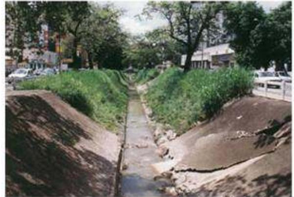
**Figura 15.** Desmoronamento da margem impermeabilizada do córrego Orozimbo Maia (enchente de 17/02/2003) (BRIGUENTI, 2005:38)
