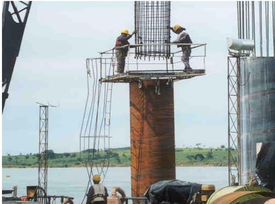
**Figura 6** – Sistema de Estações com camisa metálica perdida (Arquivo Próprio).
