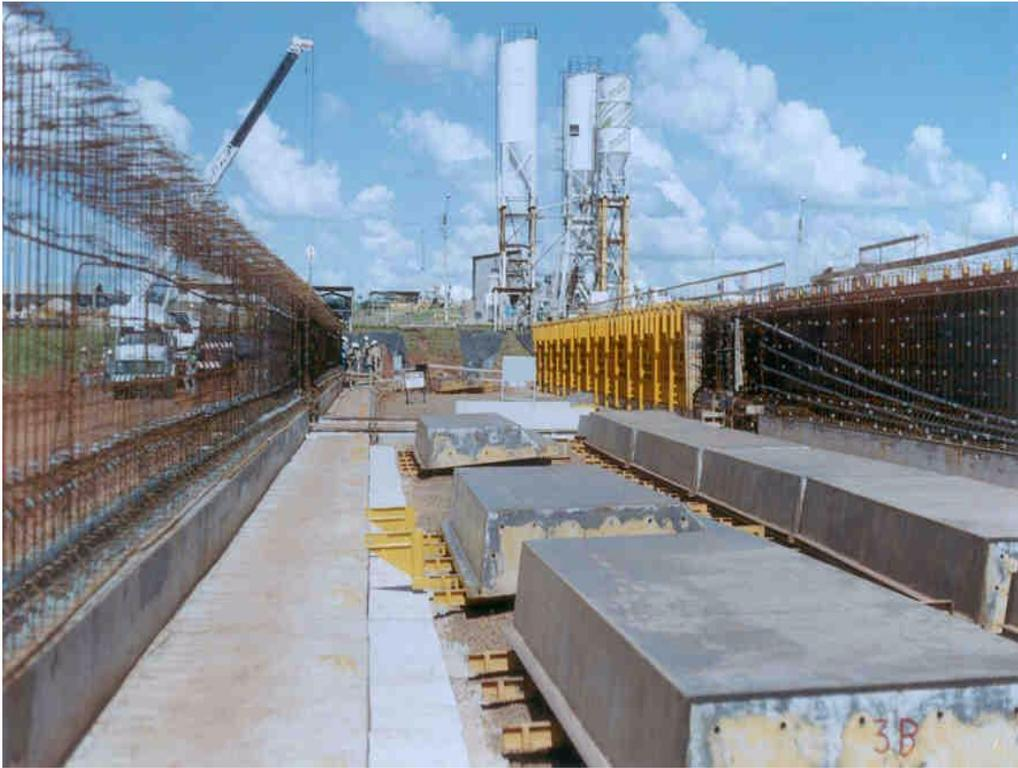
**Figura 21** –Aspecto da montagem dos painéis da forma metálica (Arquivo Próprio).
