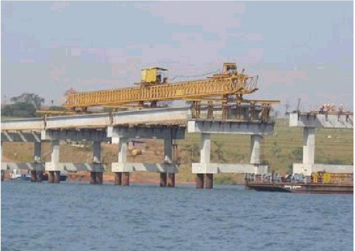
**Figura 12** – Ilustração de Treliza Lançadeira (Arquivo Próprio)
