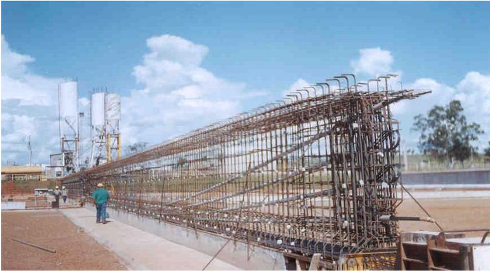
**Figura 20** – Aspecto geral da armação da viga (foco na concentração de ferragem nas cabeças das vigas) (Arquivo Próprio).
