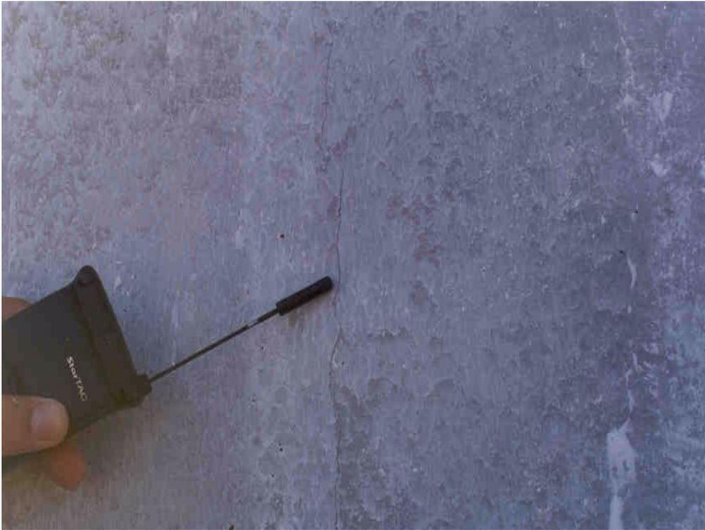
**Figura 25** Aspecto das fissuras de retração por secagem (Arquivo Próprio).
