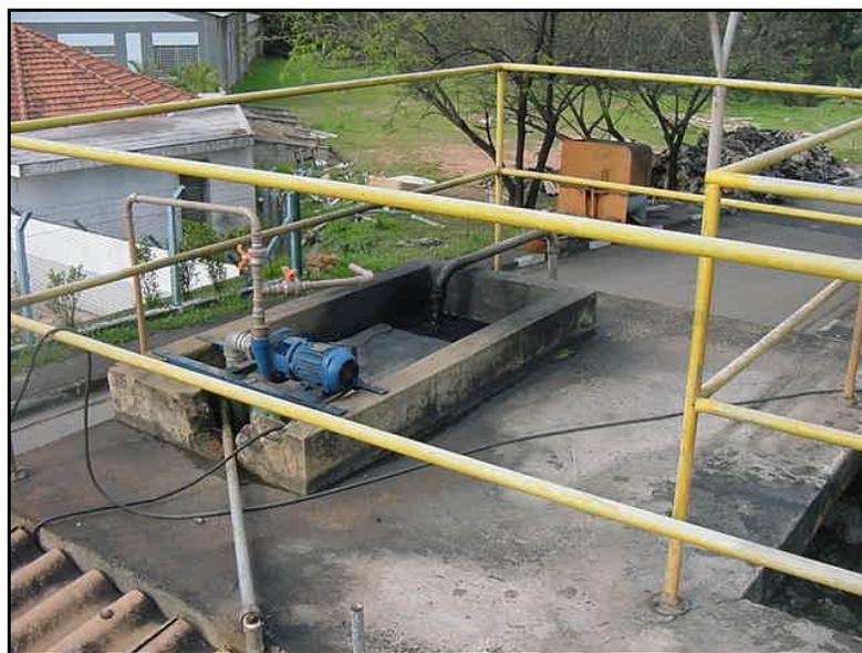
**Figura 4.4** – Aplicação de carvão ativado em pó à água bruta (ETAs 3 e 4)
