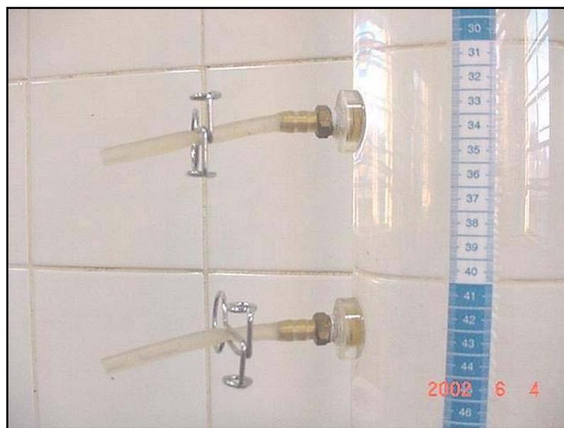
**Figura 4.11** – Pontos laterais para coleta de sobrenadante
