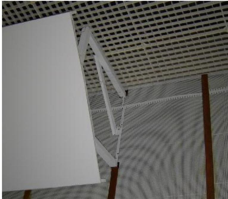
Fig 5.12. Detalhe da placa acústica, grelha do forro e lâ de rocha na parede do fundo do auditório
