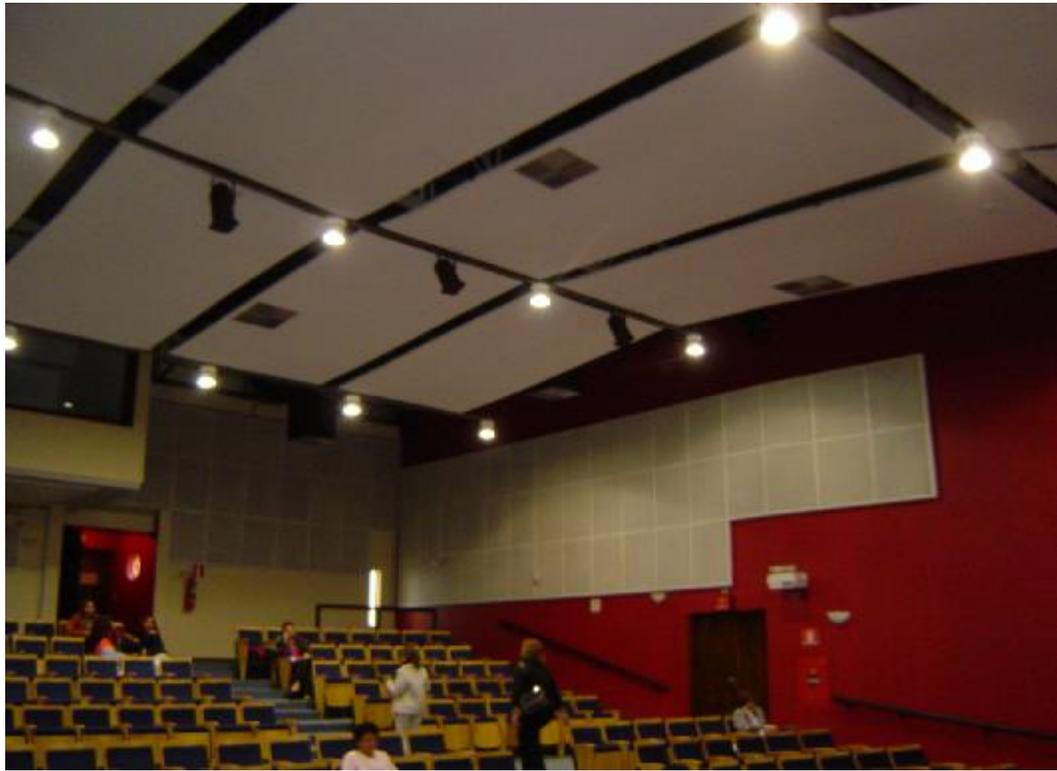
Fig 5.23. Placas acústicas da platéia e painéis absorvedores nas paredes.
