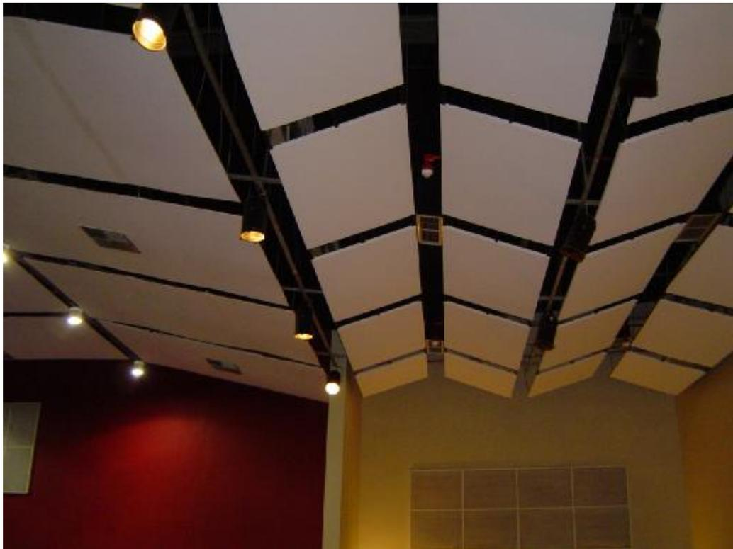
Fig 5.24. Placas acústicas do palco. Detalhe: a iluminação direta na platéia, ofusca a visão do palco.
