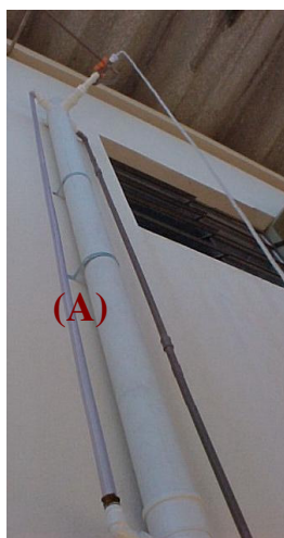
Figura 4.4 Vasos comunicantes (A) descarga de esgoto no fundo do reator (B).
