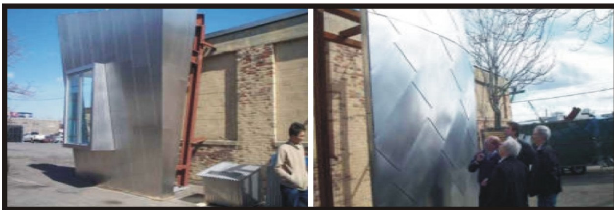
Figura 2.104: Utilização de protótipos em escala 1:1, Strata Center Fonte: Digital Design Fabrication Group, 2006 ( www.ddf.mit )
