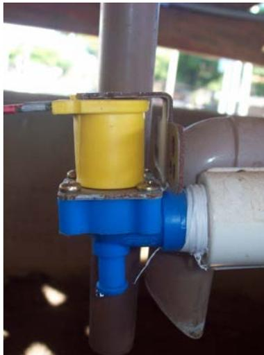
Figura 4.11: Válvula de aplicação do composto alcalino.
