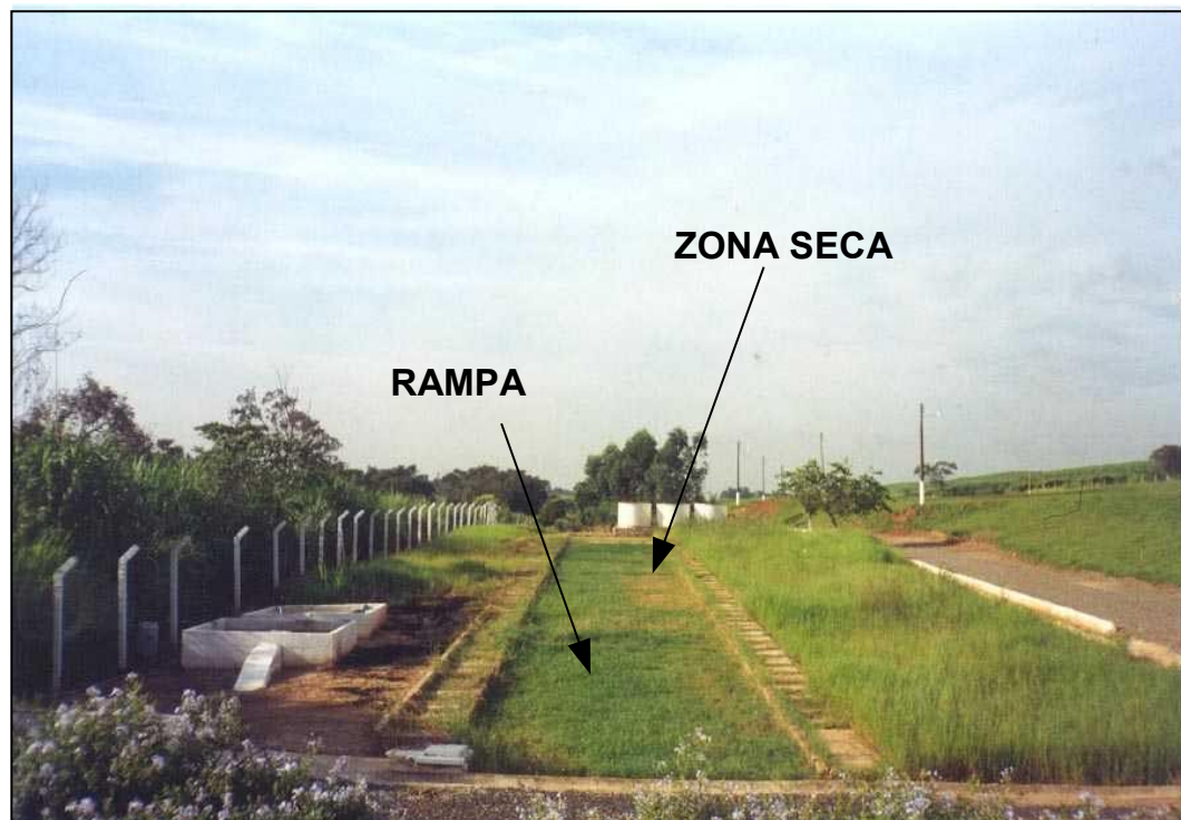
Fig. 2 - Vista geral da rampa – detalhe da “zona seca” antes da regularização
