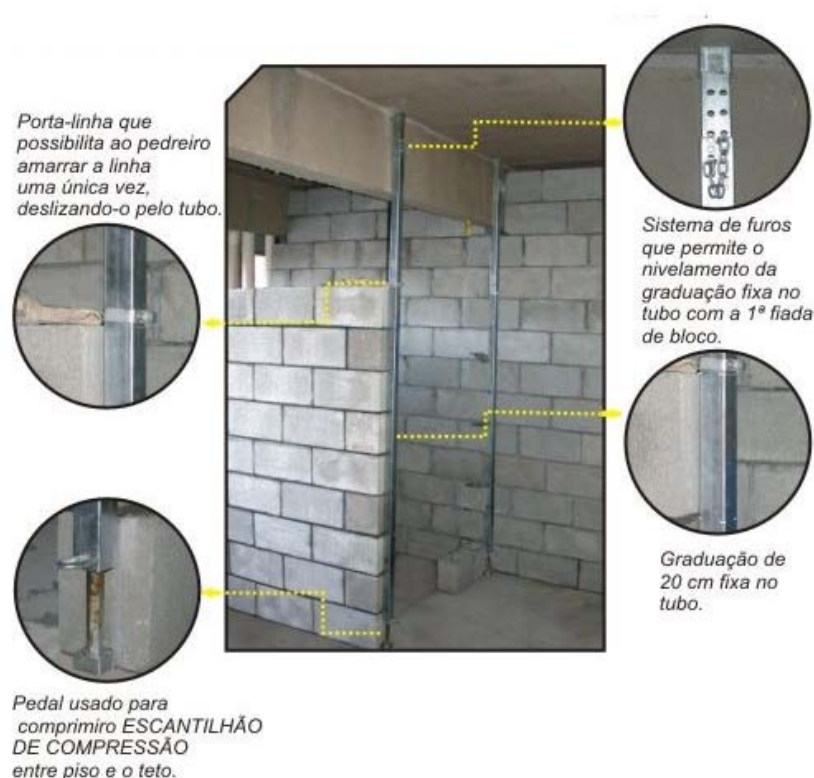
Figura 2.11 – Escantilhão para Auxiliar a Execução da Alvenaria de Vedação (Scanmetal, 2004).
