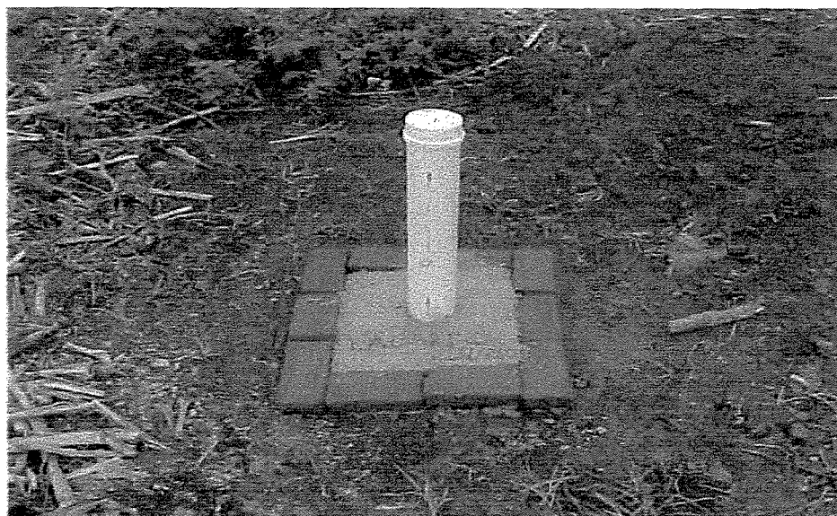
Figura 4.7: foto da cimentação dos poços.
