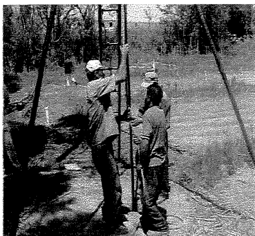
Figuras 4.8: Perfuração, Instalação (esq.) e Disposição dos Poços de Monitoramento (dir.).
