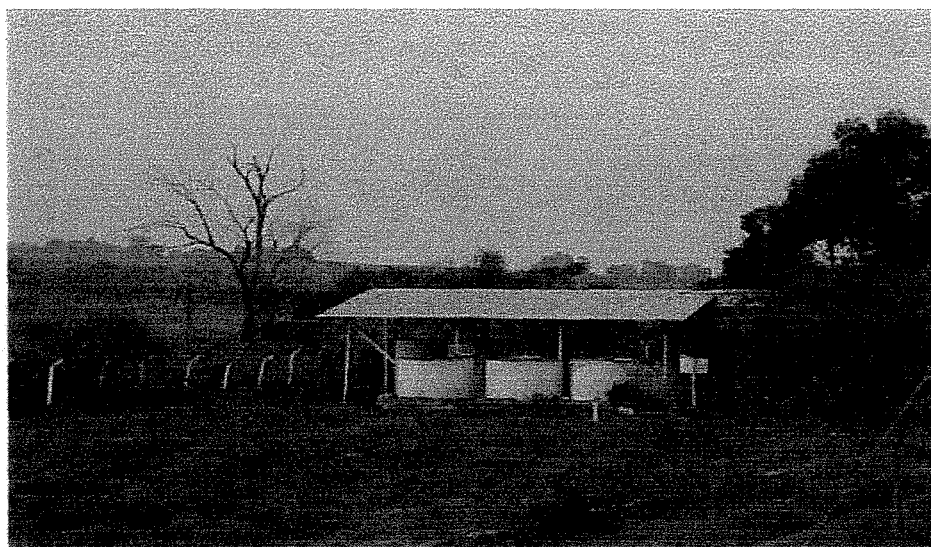
Figura 4.3. Foto dos tanques de armazenamento e distribuição do efluente.
