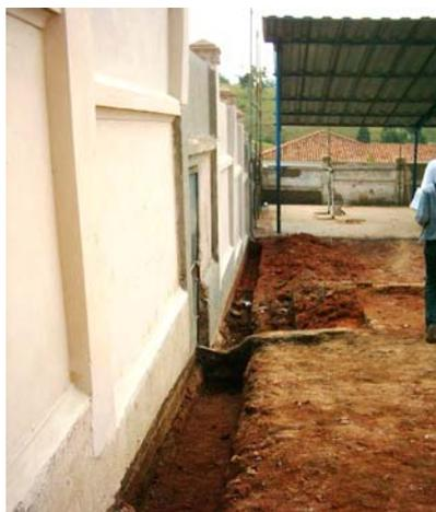
Figura 5.53 - Foto de escavação a ser isolada e sinalizada como contempla o item 10 da PIP-02-1 da Figura 5.54
