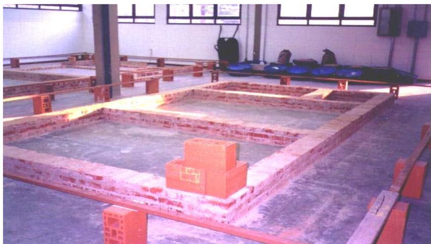
**FIGURA C 4:** Esquema de amarração de paredes e/ou fundações
