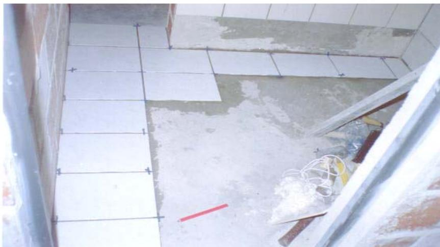
**FIGURA C 8:** Aulas de assentamento de azulejos – detalhe dos espaçadores
