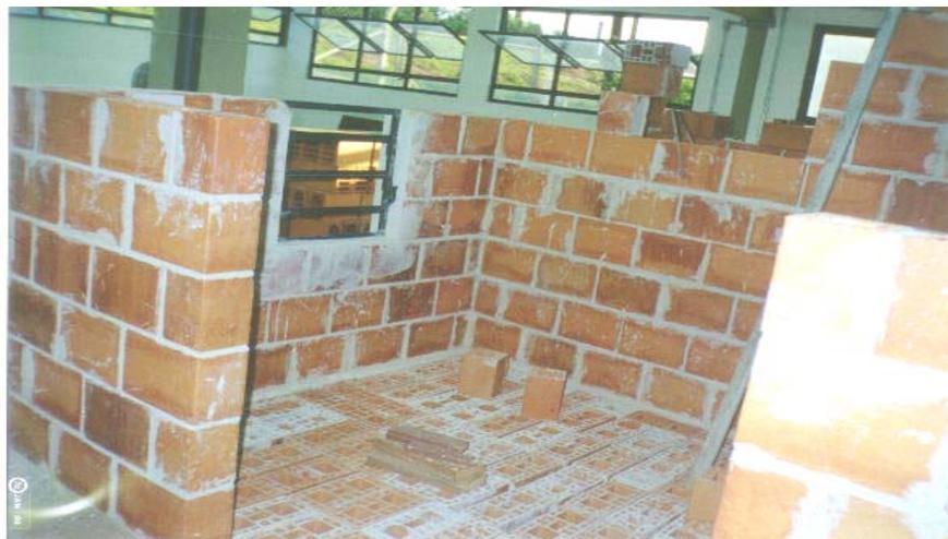
**FIGURA C 6:** Vista interna – Composição de tijolo: nas paredes e no piso
