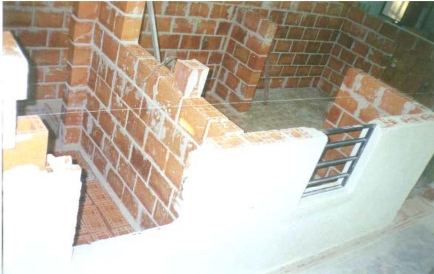
**FIGURA C 5:** Esquema da colocação de esquadrias e argamassa
