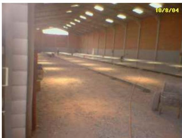
**Figura FC19** Aplicação: Piso de um galpão executado com agregados reciclados.
