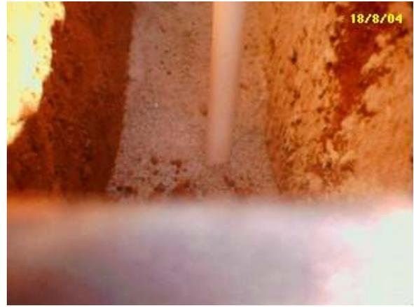
**Figura FC22** Aplicação : Detalhe do lastro em agregado reciclado.
