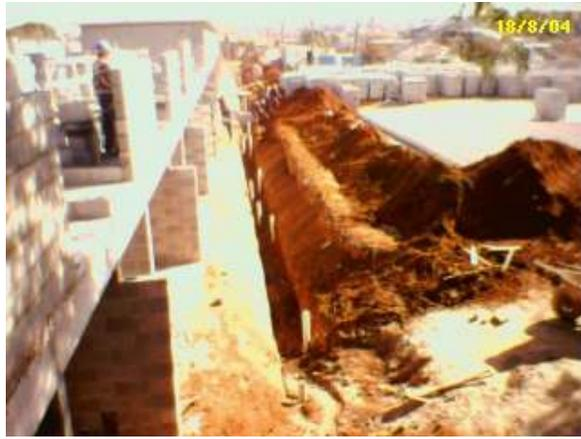
**Figura FC21** Aplicação : Lastro para assentamento da infra-estrutura.
