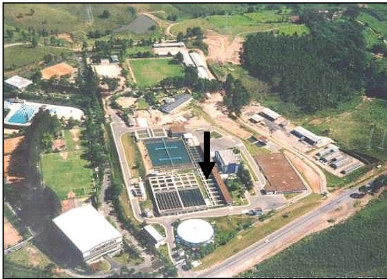
Figura 13: fotografia aérea da ETA 3 e 4 em Sousas (SANASA)
