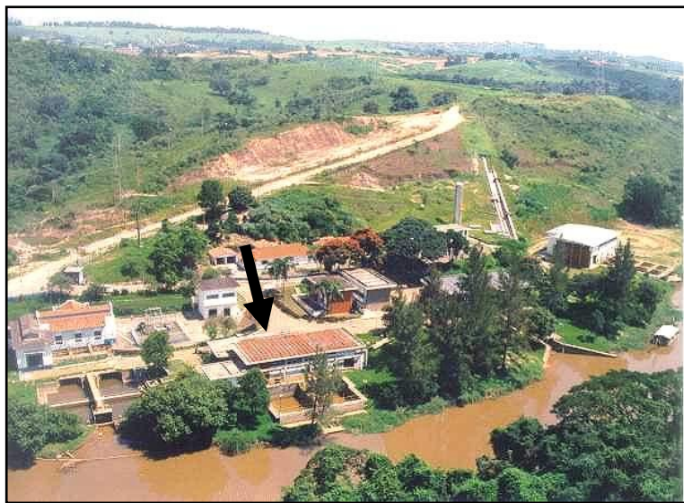
Figura 14: Fotografia aérea do ponto de captação das ETAs 3 e 4
