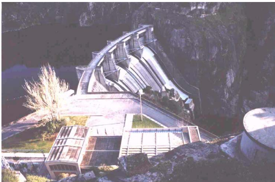
Figura 1.16.b: Barragem à arco
