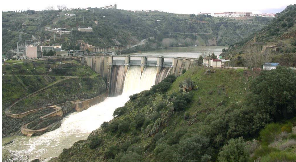
Figura 1.16.a: Barragem à gravidade
