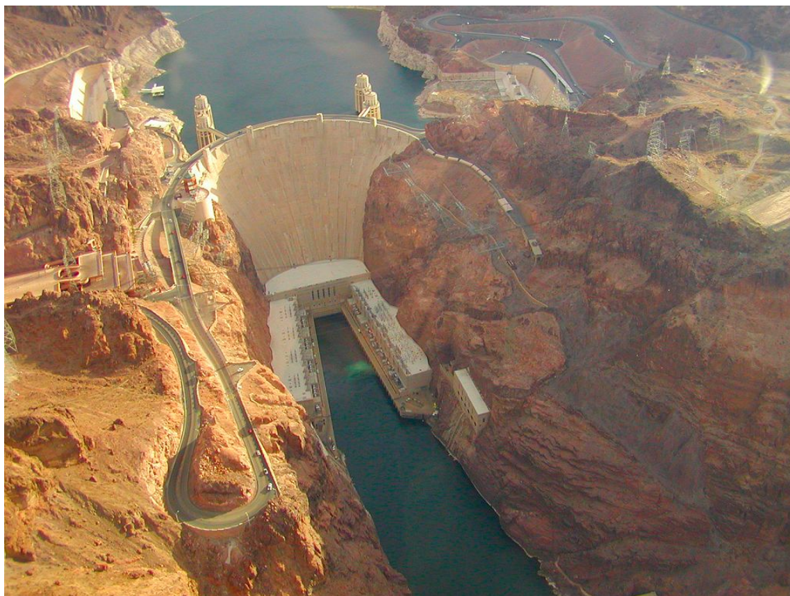
Figura 1.16.c: Barragem à arco
