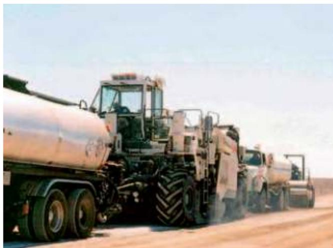
Figura 2.7- Equipamentos em reciclagem com espuma de asfalto.
