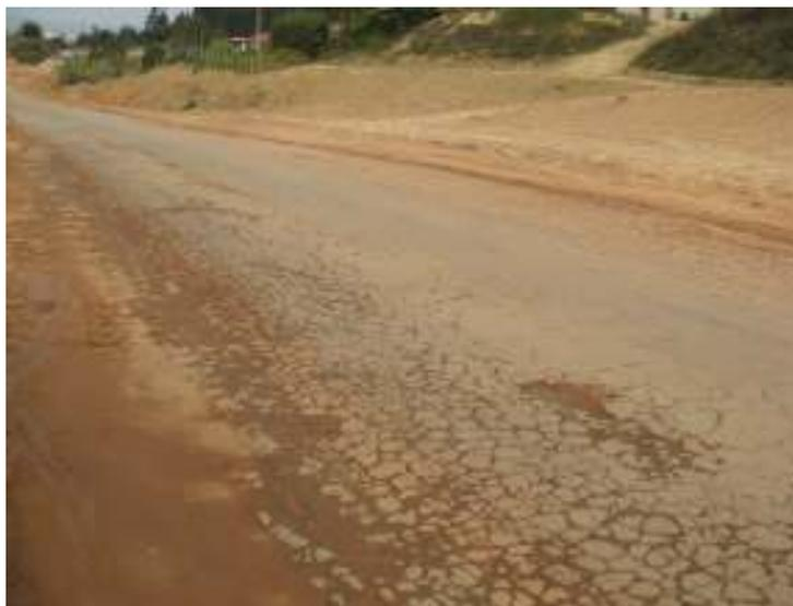
Figura 2.1- Pavimento deteriorado com trincas em blocos (BR 459- trecho Pouso Alegre- MG- Congonhal- MG).
