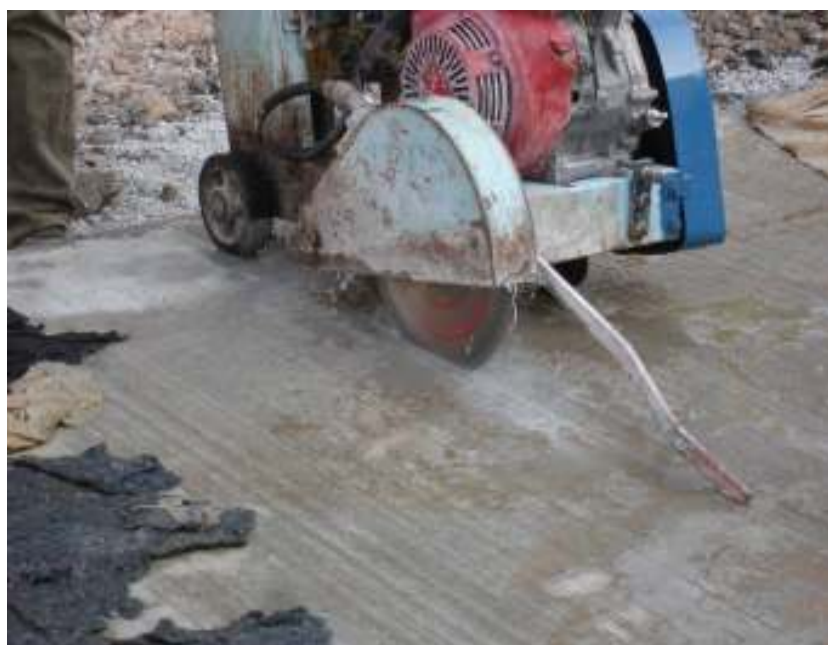
Figura 6 - Corte de juntas
