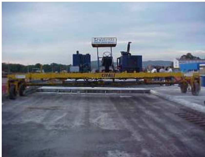
Figura 4 - Equipamento utilizado no Rodoanel de São Paulo
