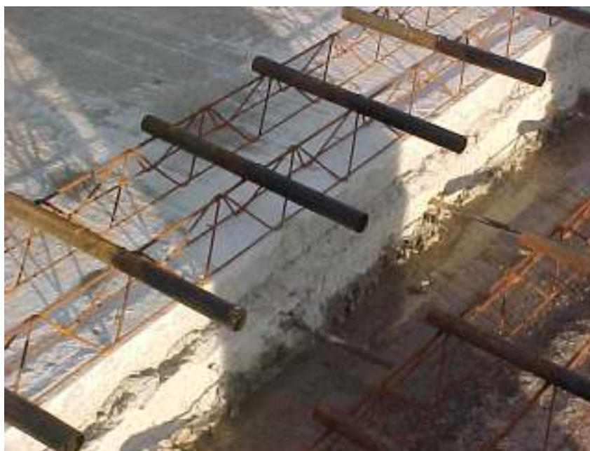
Figura 3 - Barras de transferência e de ligação
