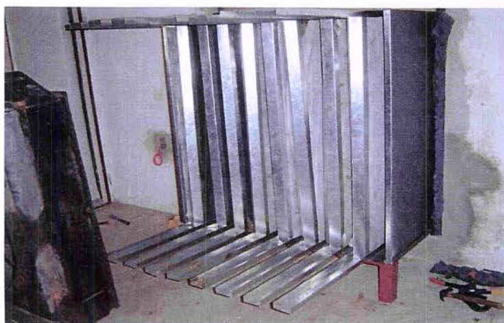
Foto 6 Atenuador durante a montagem do prolongamento do Prolongamento do duto.
