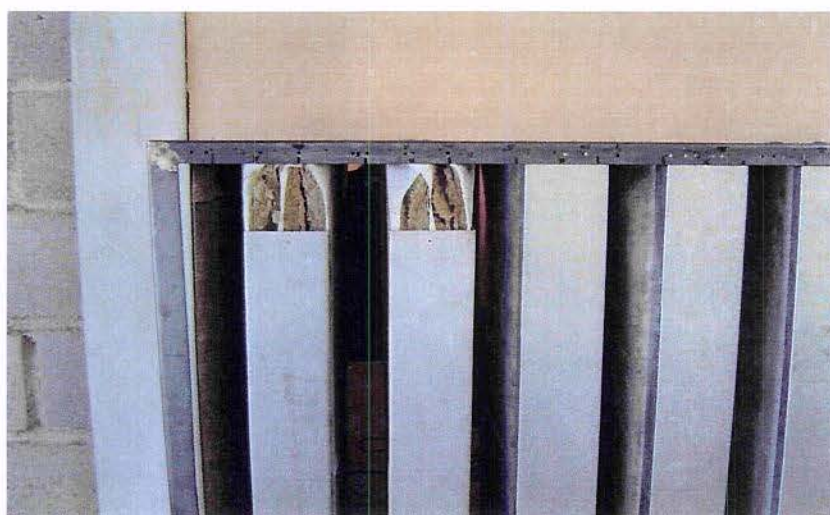
Foto 5 Detalhe da lamela de 50mm mostrando o material absorvente
