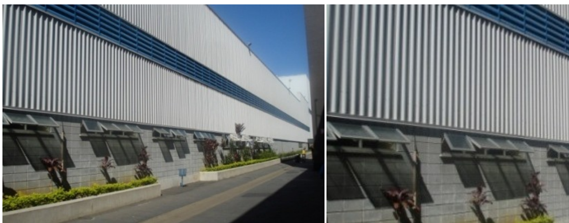
FIGURA 4.11 – Utilização de fechamento em alvenaria de blocos e painéis metálicos termo acústicos
