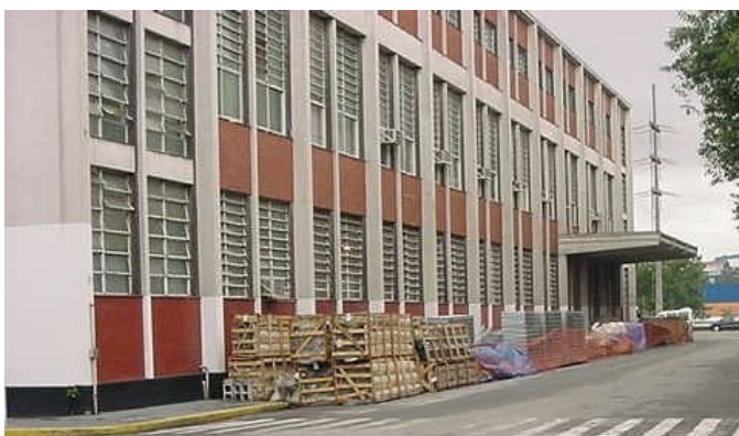
FIGURA 4.8 – Edifício industrial da década de 1960
