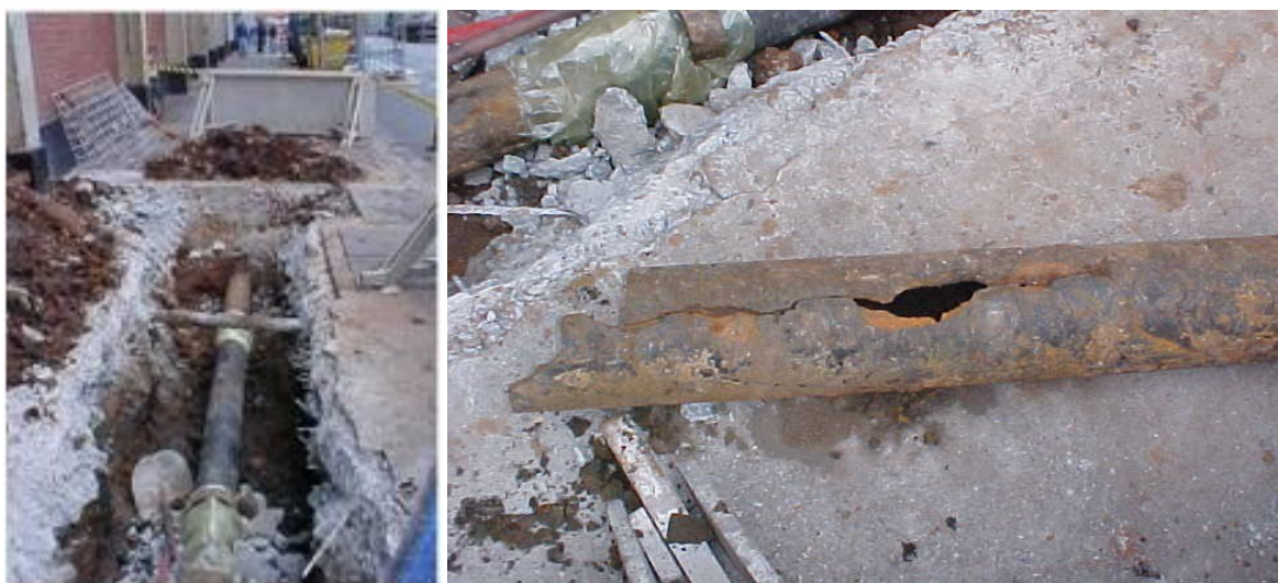
FIGURA 4.22 – Utilização de tubulações de distribuição enterradas no solo
