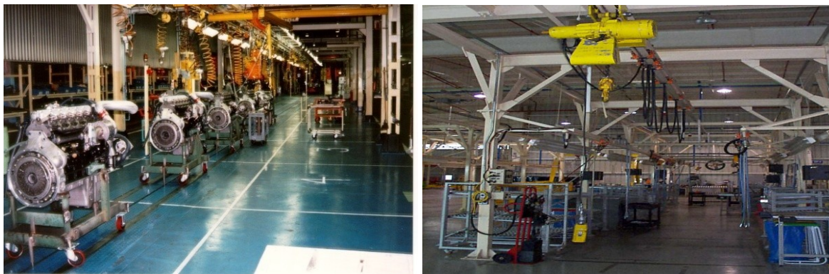
FIGURA 4.18 – Pórticos como elemento de fixação de equipamentos
