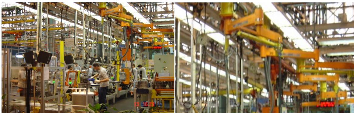
FIGURA 4.16 – Estrutura da cobertura como elemento de fixação de equipamentos
