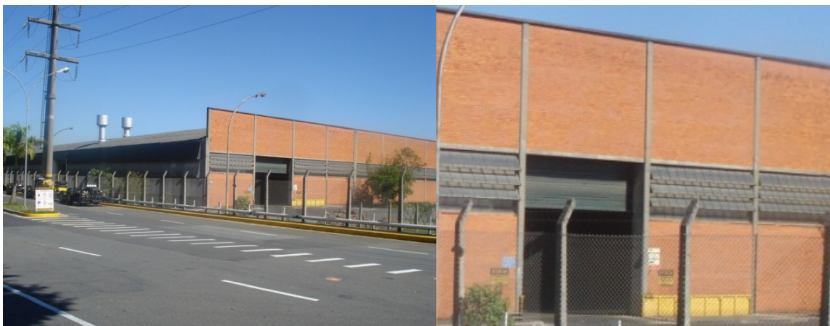
FIGURA 4.9 – Utilização de fechamento com alvenaria de tijolos
