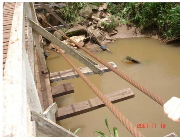
**Figura 6.47 – Cabos de aço expostos**
