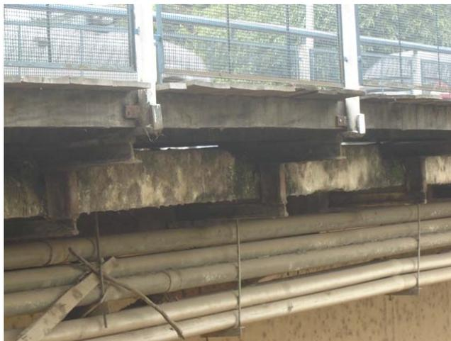
**Figura 6.4 – Tubulações fixadas na estrutura**
