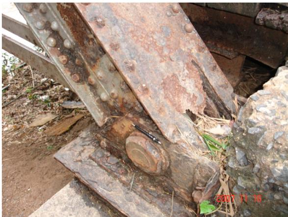
**Figura 6.18 – Corrosão avançada do aço**
