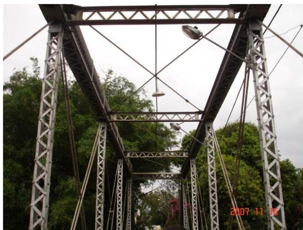
**Figura 6.22 – Vista dos contraventamentos da estrutura**
