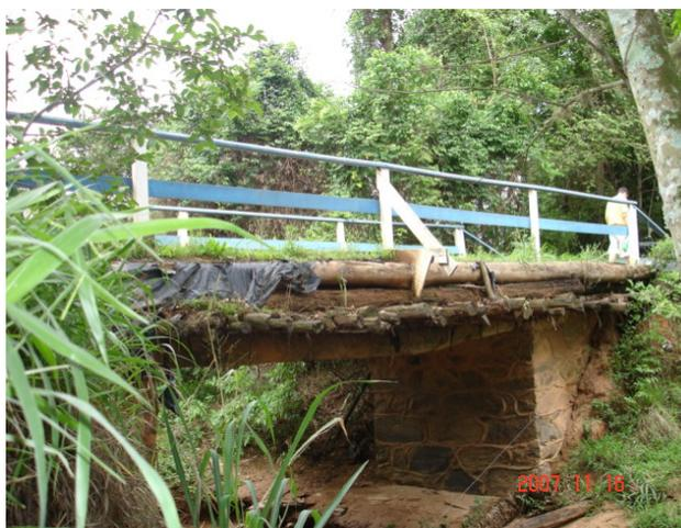
**Figura 6.29 – Deformação excessiva no meio do vão da ponte**
