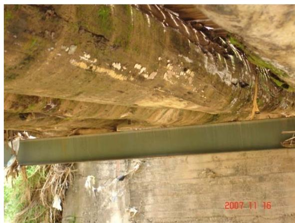
**Figura 6.49 – Transversina metálica**
