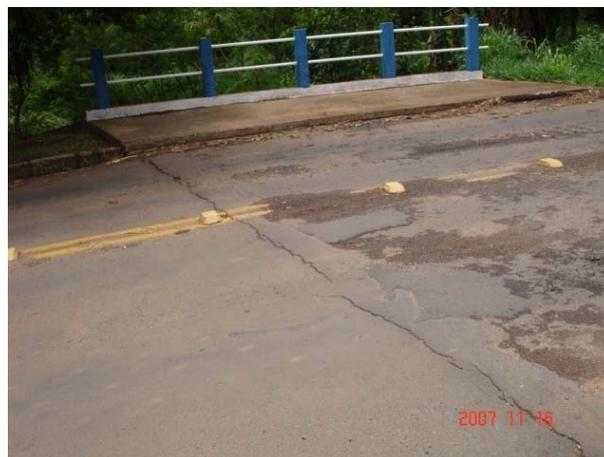
**Figura 6.45 – Deterioração do pavimento**
