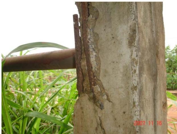
**Figura 6.32 – Deterioração do guarda-corpo por corrosão**
