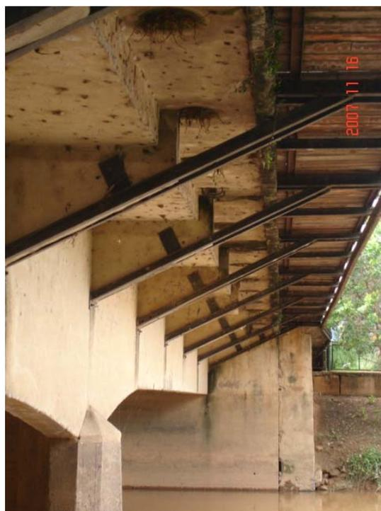
**Figura 6.3 – Estrutura metálica que sustenta o passeio**
