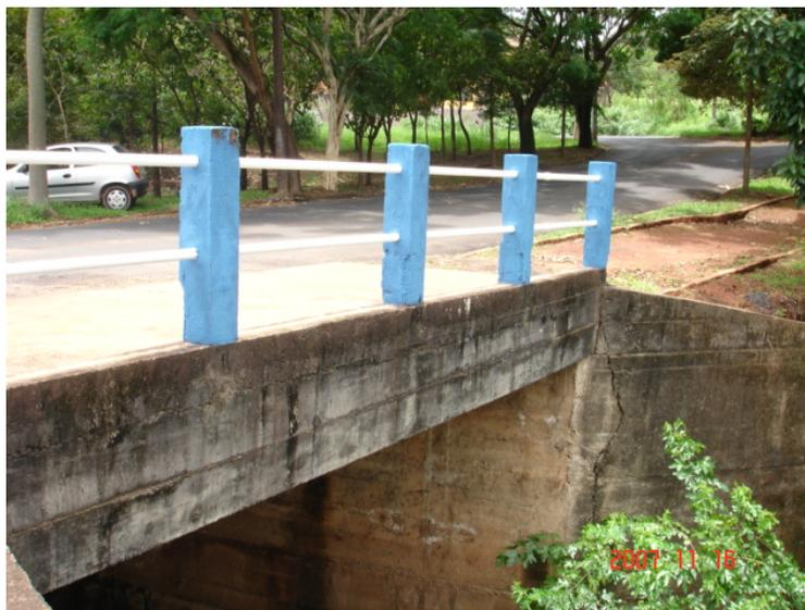
**Figura 6.42 – Rachaduras nos encontros indicando excesso de sobrecarga**
