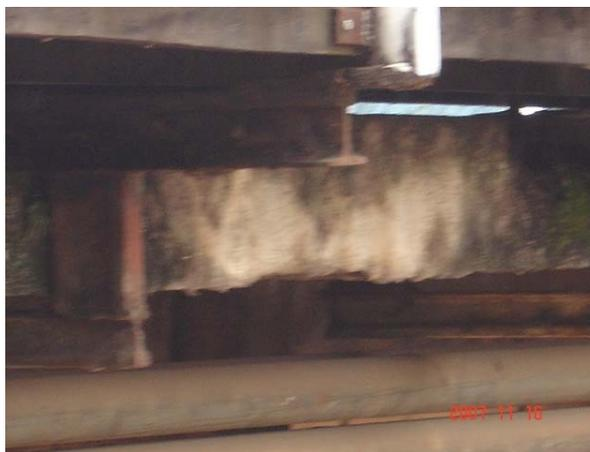
**Figura 6.8 – Corrosão na estrutura metálica que sustenta o passeio**
