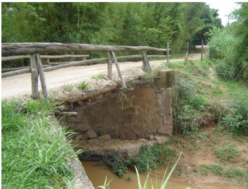
**Figura 6.39 – Encontro parcialmente descalçado por efeito da erosão e má execução**
