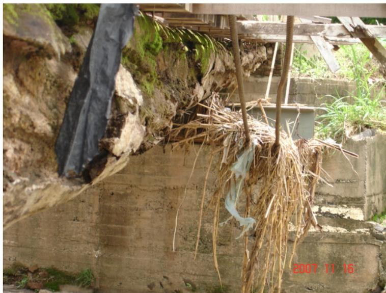
**Figura 6.51 – Apodrecimento das toras de madeira que compõem a estrutura principal**
