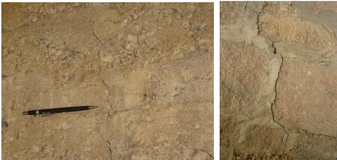
**Figura 5.38 – Rachaduras nos encontros indicando excesso de sobrecarga**
