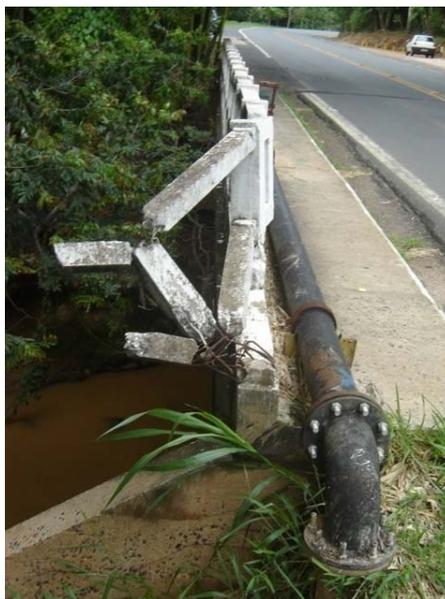
**Figura 6.57 – Guarda-corpo parcialmente destruído por colisão de veículo**
