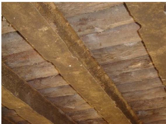
**Figura 6.35 – Corrosão dos perfis**
