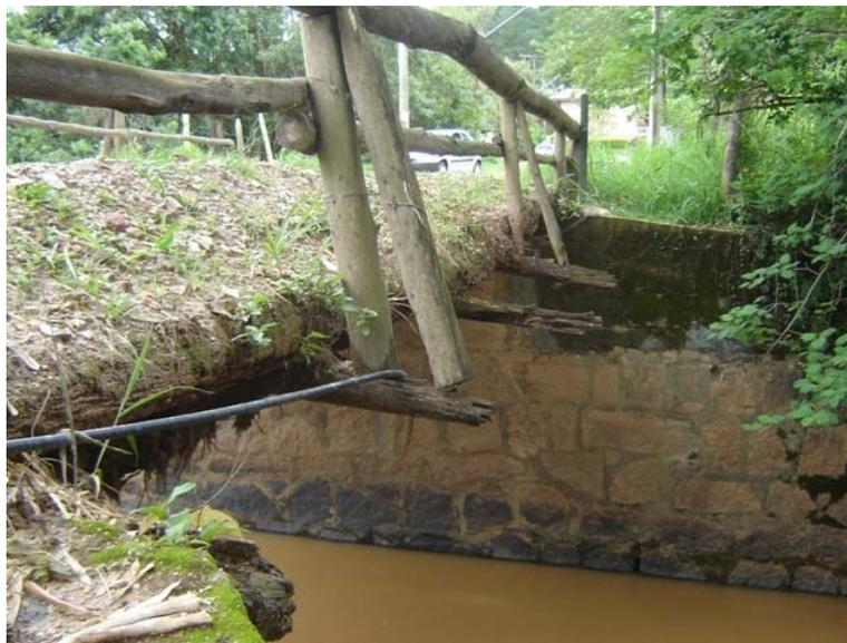
**Figura 6.40 – Guarda-corpo de madeira em estado precário**
