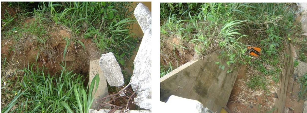
**Figura 6.58 – Erosão e assoreamento junto ao encontro**
