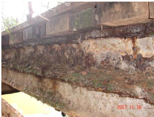
**Figura 6.20 – Corrosão avançada dos perfis metálicos**
