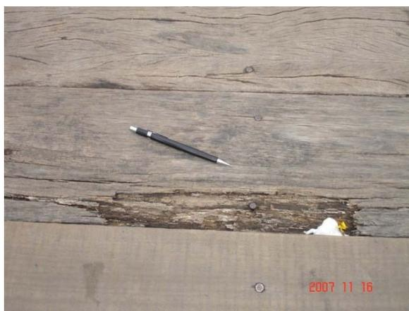
**Figura 6.10 – Saliência causada pelo apodrecimento da madeira**
