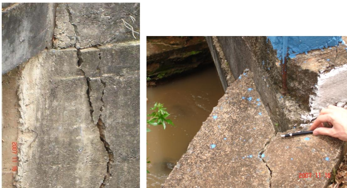
**Figura 6.43 – Detalhes das rachaduras dos encontros**
