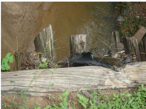
**Figura 6.27 – Deterioração da madeira**
