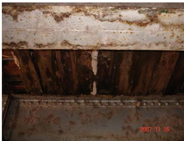
**Figura 6.21 – Apodrecimento da madeira do tabuleiro por acúmulo de umidade**
