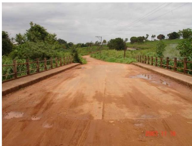
**Figura 6.33 – Tabuleiro com presença de solo e lama**
