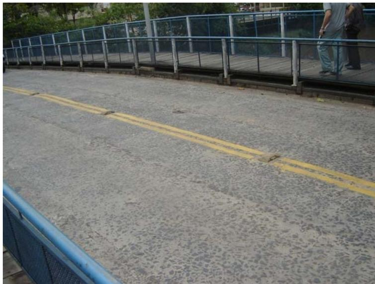
**Figura 6.9 – Desgaste do concreto da laje do tabuleiro**
