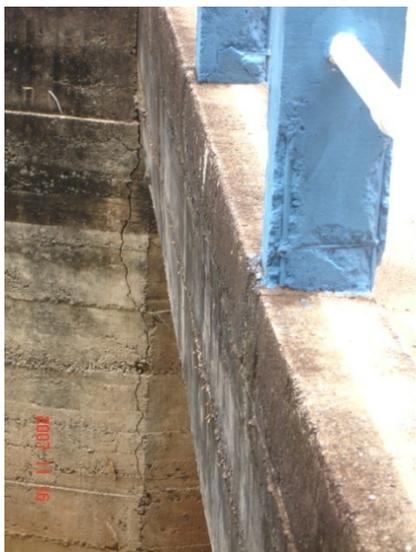
**Figura 6.44 – Corrosão do aço dos guarda-corpos**
