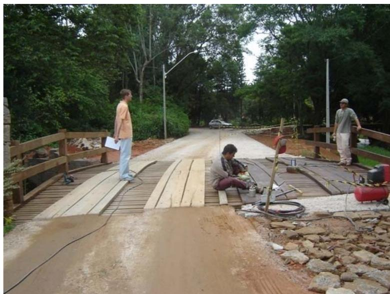
**Figura 6.59 – Ponte de madeira em fase de acabamento**
