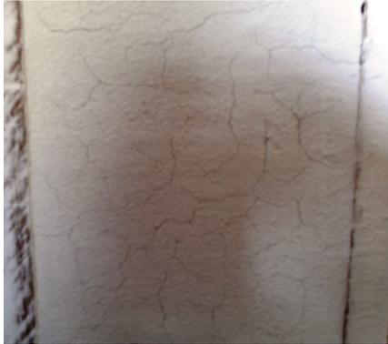
Figura 4.66 – Detalhe - Bloco cerâmico de alvenaria estrutural depois da aplicação de revestimento de pasta de gesso reciclado fino calcinado a 150 °C.
