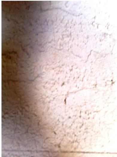
Figura 4.63 – Bloco cerâmico de alvenaria estrutural depois da aplicação de revestimento de pasta de gesso reciclado grosso calcinado a 150 °C.
