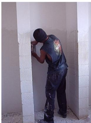
Figura 2.6 – Aplicação manual de pastas de gesso como revestimento de parede.
