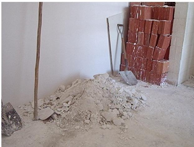
Figura 3.2 - Gesso residual gerado durante a aplicação de pasta de gesso como revestimento interno de paredes.
