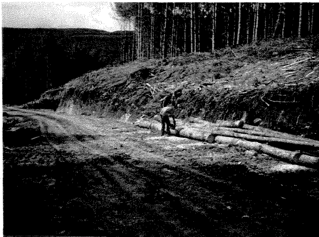
Figura 21 - Operação de traçamento
