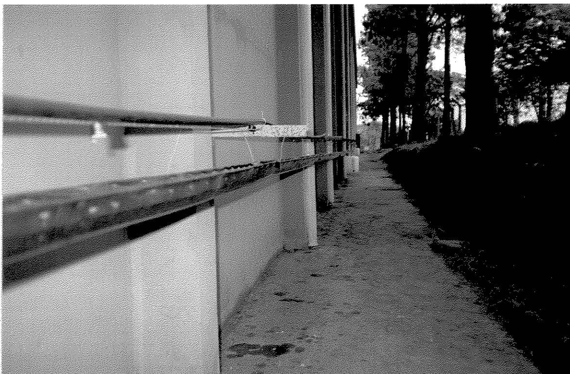
Figura 13 - Detalhe da calha de lona plástica.
