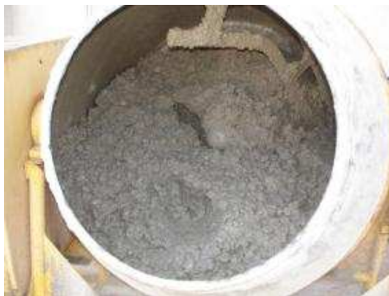
Figura 7.9 – Mistura do concreto em betoneira elétrica
