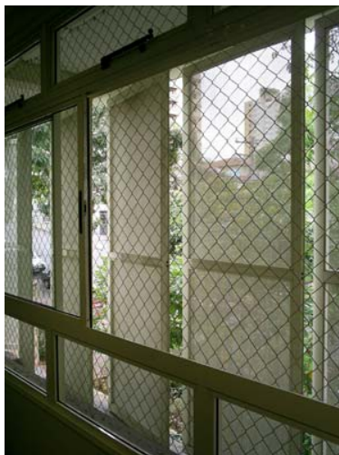
Figura 30 : Brise pivotante de tela perfurada Fonte: A autora, 2006
