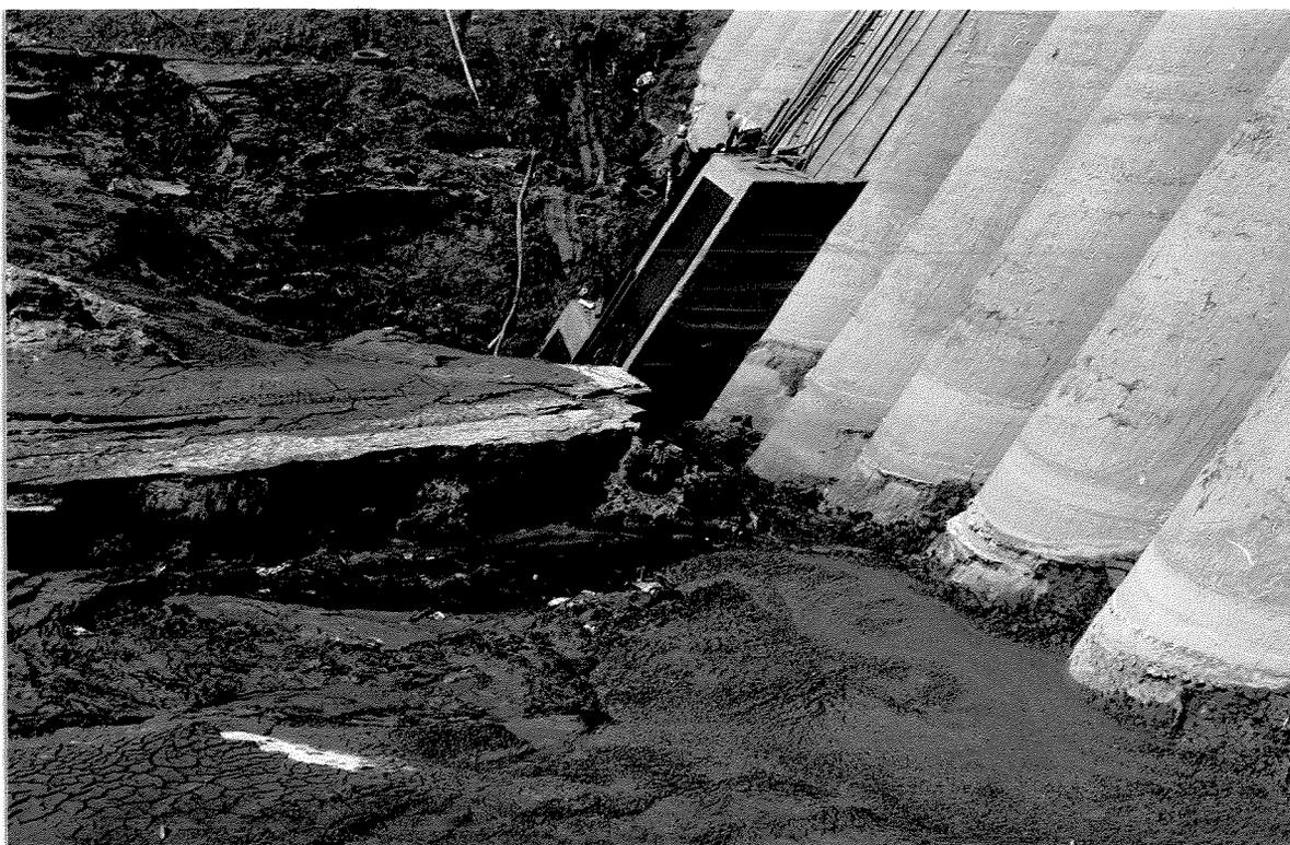
Figura 1.1: Tomada d'água e descarga de fundo com assoreamento em Cariobinha
