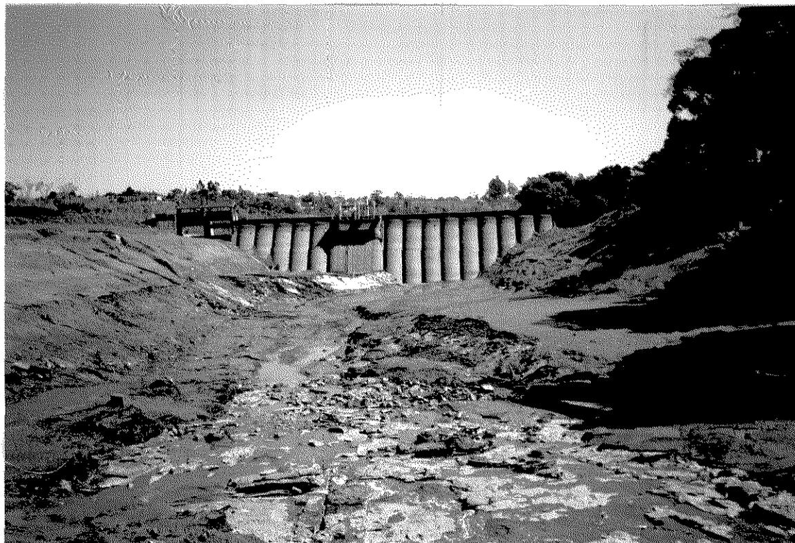
Figura 1.3: Visão geral do reservatório vazio com bancos de areia ao pé da barragem
