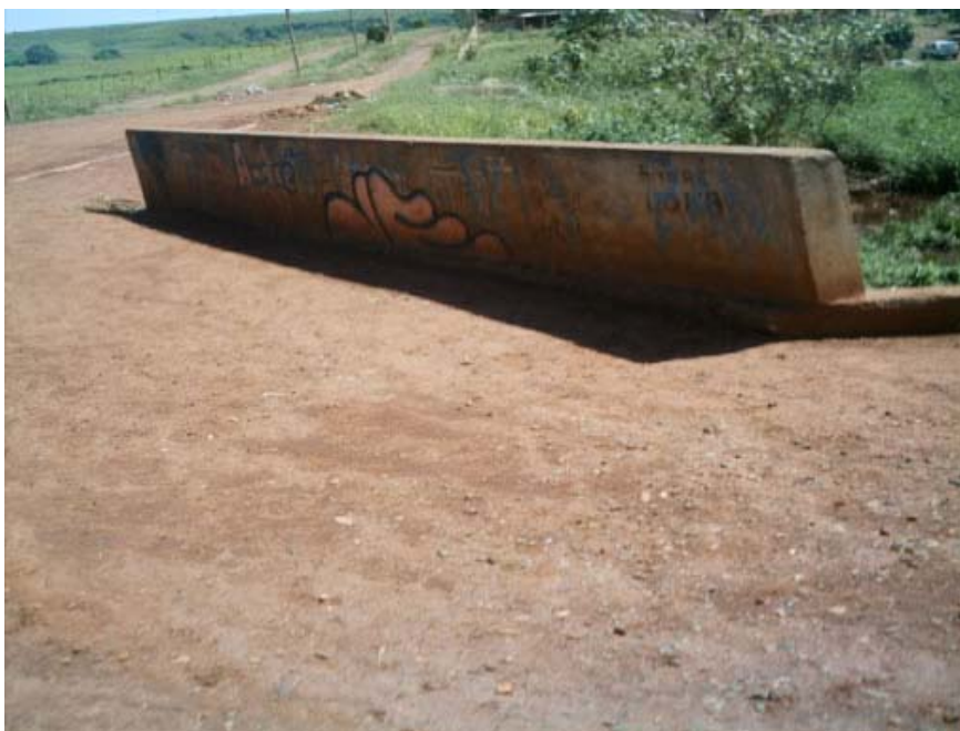
Figura 5.5 - Vista da localização do ponto AS 02.
