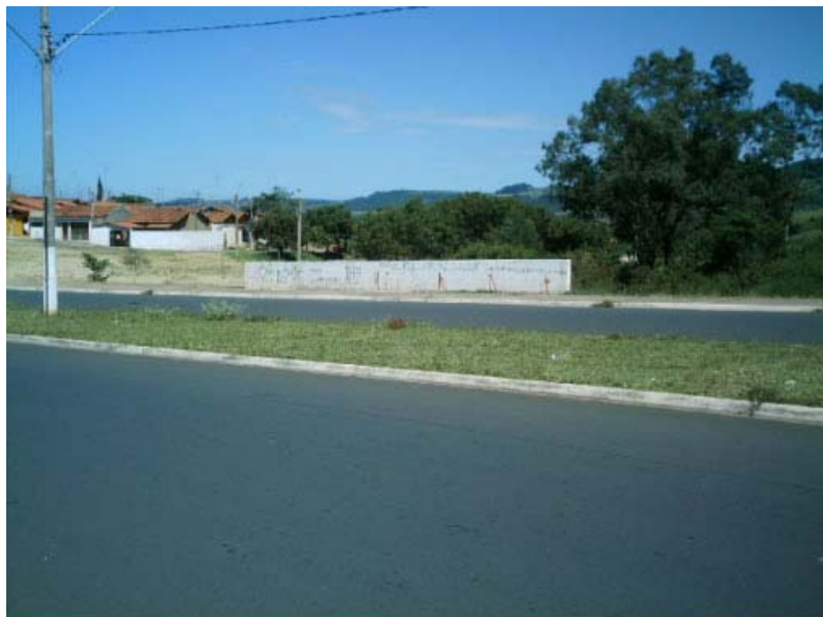
Figura 5.3 - Vista da localização do ponto AS 01.
