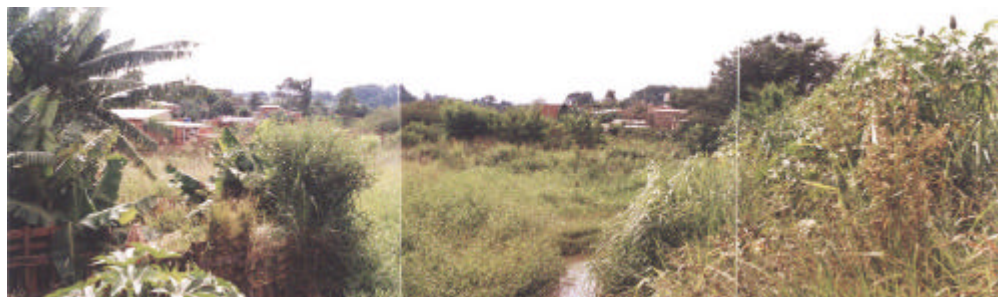
FIGURA 6.4: EDIFÍCIOS NA PLANÍCIE DE INUNDAÇÃO – JARDIM MARISA
