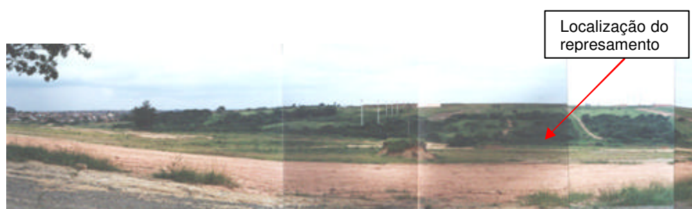
FIGURA 6.6: REPRESAMENTO DO RIBEIRÃO DENTRO DA ÁREA DO AEROPORTO
