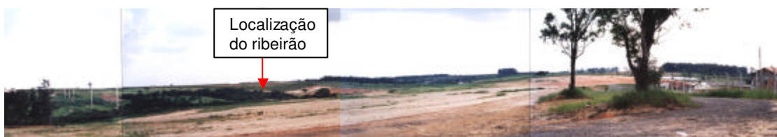
FIGURA 5.36: SOLO TOTALMENTE EXPOSTO ÀS MARGENS DO RIBEIRÃO VIRACOPOS – AEROPORTO / J. ESPLANADA
