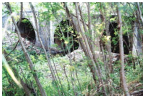
FIGURA 5.42: CANALIZAÇÃO DO VIRACOPOS SOB A ROD. SANTOS DUMONT
