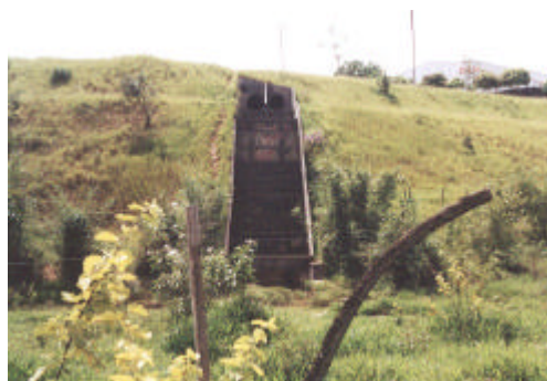
FIGURA 5.37: DESCARGA DE ÁGUA PLUVIAL DA EMPRESA DAIMIER CHRYSLER DO BRASIL LTDA. NO RIBEIRÃO
