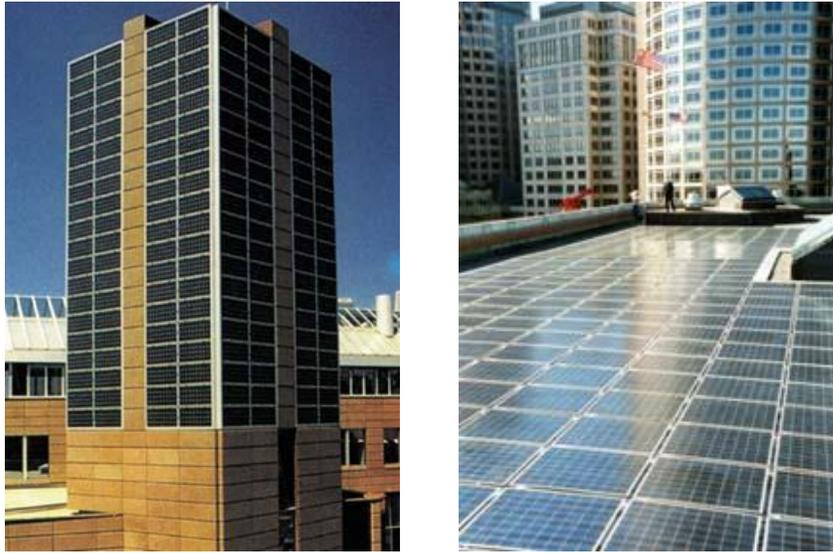
**Figuras 4.7 e 4.8 - Painéis Fotovoltaicos Aplicados na Fachada e Painéis Aplicados na Cobertura e Terraço**
