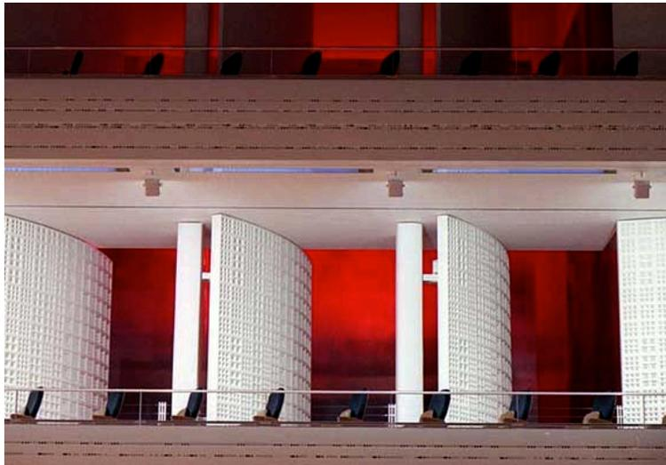
Figura 4.31: Detalhe das portas móveis que acoplam a sala com a câmara reverberante em Lucerne, Suíça.
