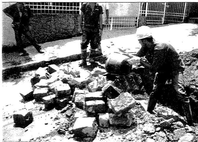
Figura 08 – Execução de manutenção em vazamento (DMAE-Poços de Caldas)
