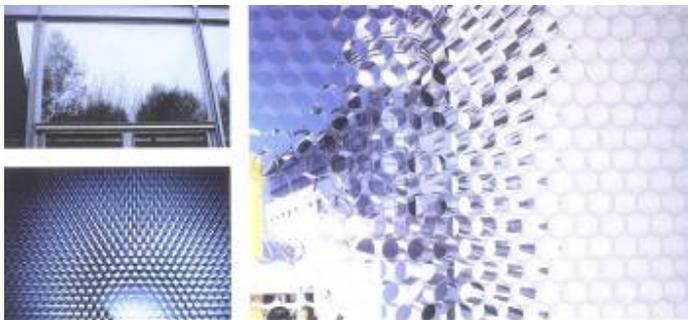
Figura 1.63 – Tubos em vidro, colocados no interior das lâminas de vidro de janelas, *helioram*
