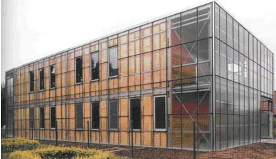
Figura 2.36 – Vista das fachadas: leste em madeira com vidro e norte toda em vidro impresso
