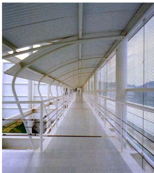
Figura 2.19 – Vista interna da passarela com o vidro serigrafado
