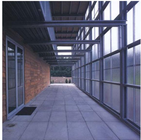
Figura 2.37 – Vista interna da circulação com vidro impresso
