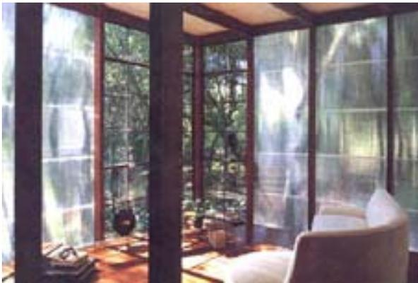
Figura 1.54 – Vista interna da residência em policarbonato translúcido
