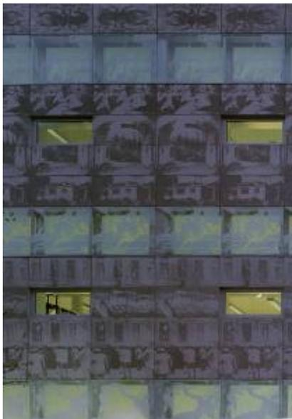
Figura 2.3 – Aberturas na fachada em vidro transparente
