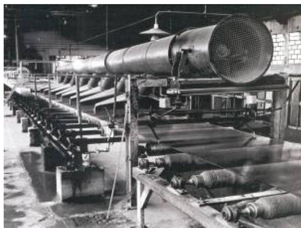
Figura 1.50 – Vista interna da União Brasileira de Vidros, produção de vidro impresso
